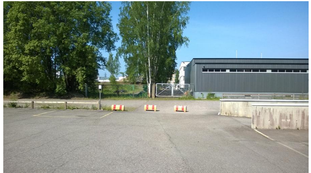
Näkymä Kirvesmiehenkatu 4 sisäpihalta länteen
