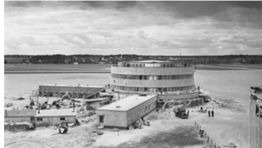
Terminaalin rakennustyöt 1937-38. (Pietinen / MV)
