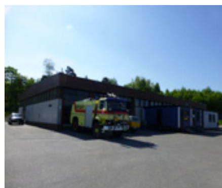
5. Autosuoja ja huoltorakennus
