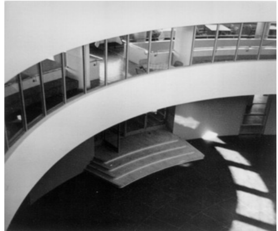
Terminaalin keskihalli sekä ravintolaan ja odotustilaan johtava porras 1938. (Iffland / KA)
