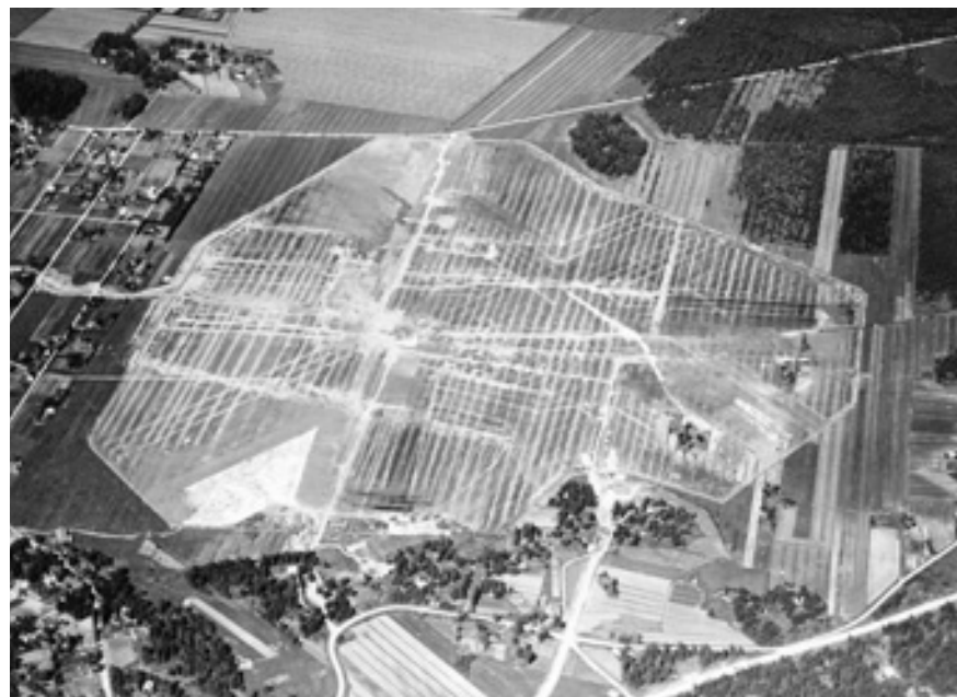
Kentän salaojitustyöt käynnissä vuonna 1936. (SIL)
