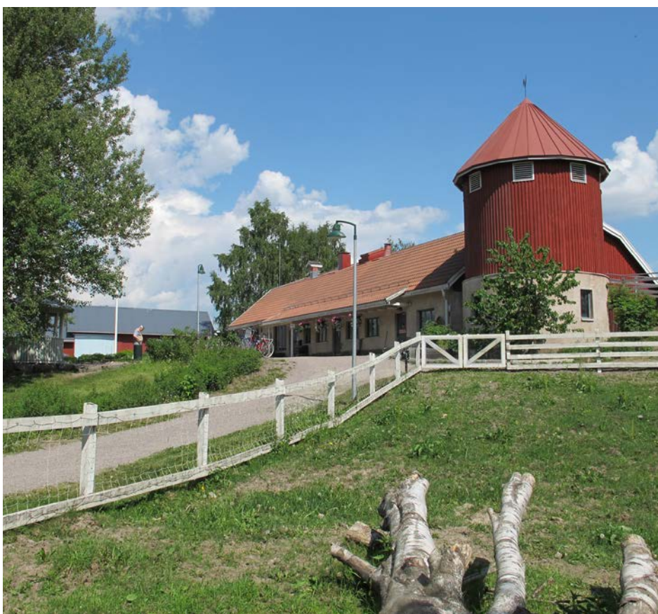
Kotieläintilan päärakennus, asuinrakennus on purettu ja sen paikalla on nykyään huvimaja. Ympäri on kasvanut haavikko. 2016.
