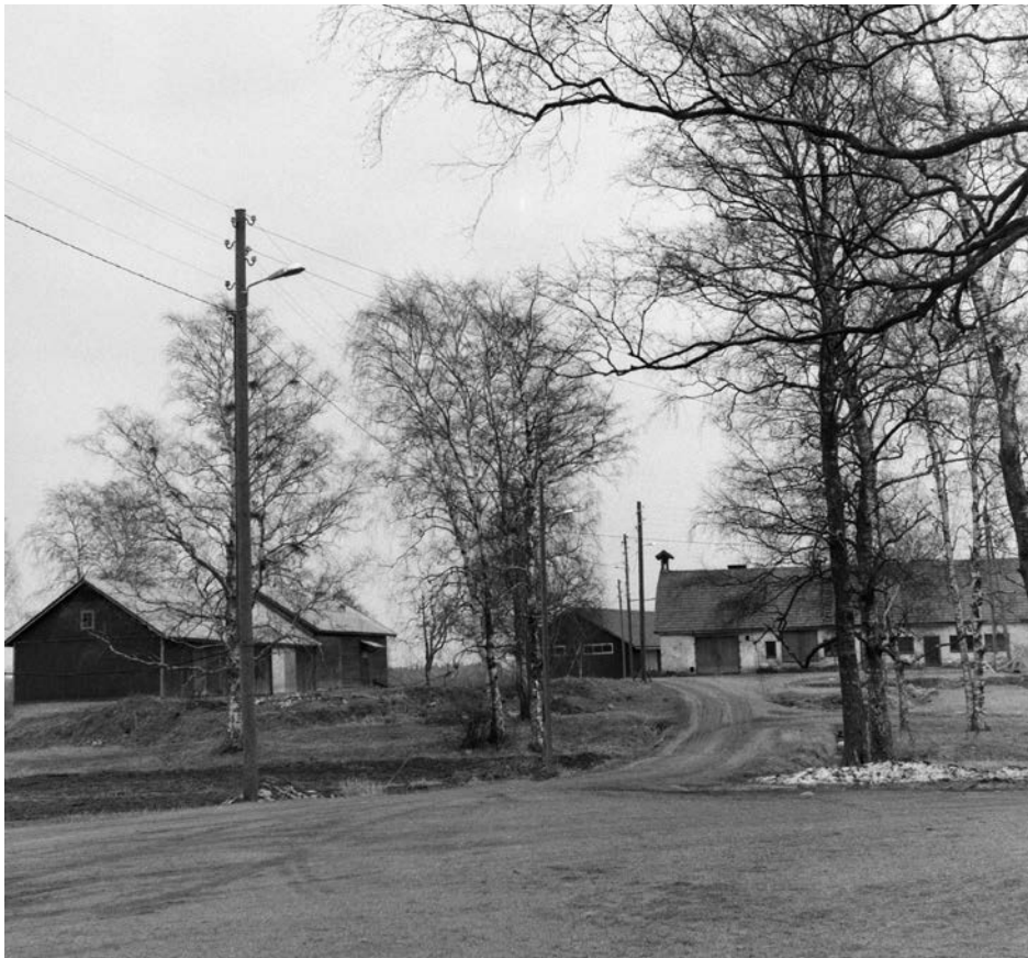
Vasemmalla ylivaja, viljamakasiini, liiteri, autotalli ja sikala. Sikalan vieressä ollut asuinrakennus on purettu, 1967 kuvassa se vielä näkyy. 1969.
