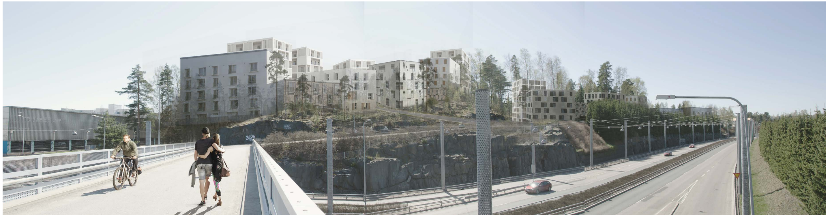
Näkymä Vuotien pohjoispuolelta kohti Pohjavedenpuistoa. Vasemmalle puolelle jää Kallahden asuinalue.
