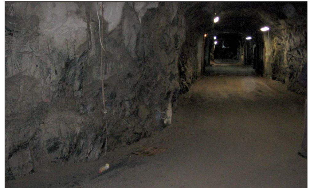
Kuva 11. Hiekkasiilon paljasta kallioseinää
