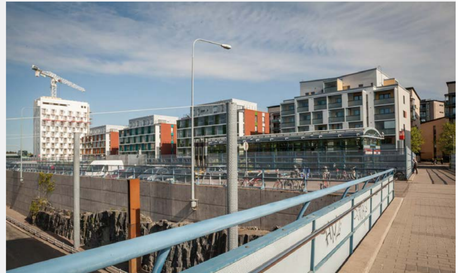
RASTILAN METROASEMAN POHJOISPUOLI
