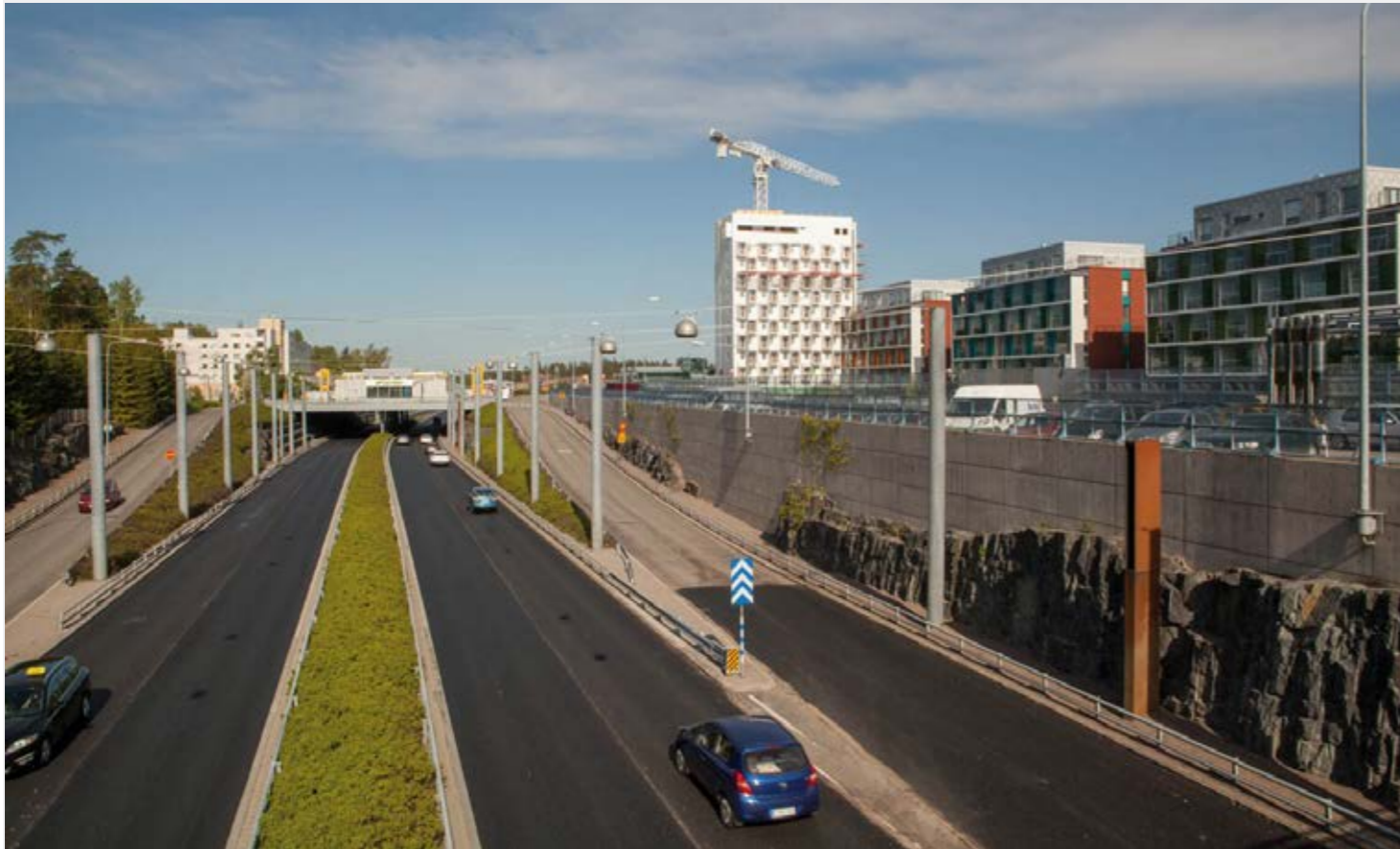
NÄKYMÄ RASTILAN METROASEMALLE VUOSAAREN KESKUSTAN SUUNNASTA
