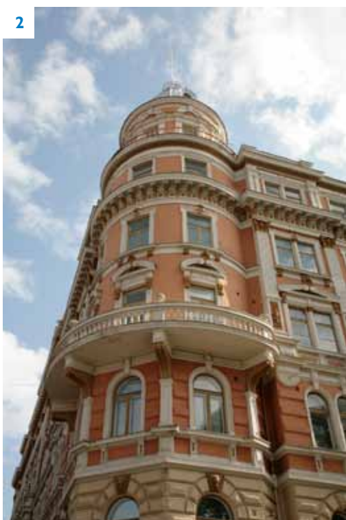
Kulmatornin muotoilu vaihtuu alempien kerrosten kulmikkuudesta pääkerroksen kohdalla pyöreäksi.
