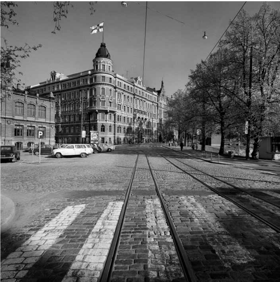
Korkeavuorenkadun puoleinen julkisivu 1980-luvun asussaan. Kuvaaja Simo Rista. HKM KA.
