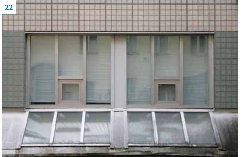
Uuden pihasiiven julkisivuote alumiini-ikkunoineen.
