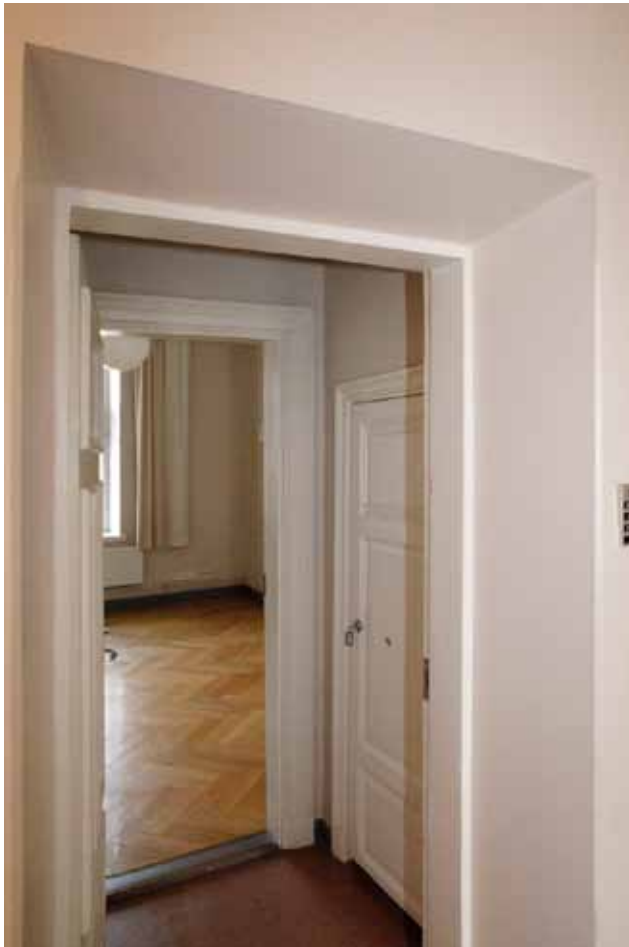
5. kerroksen toimistohuoneessa 518 on on jäljellä alkuperäisiä komerotiloja.
