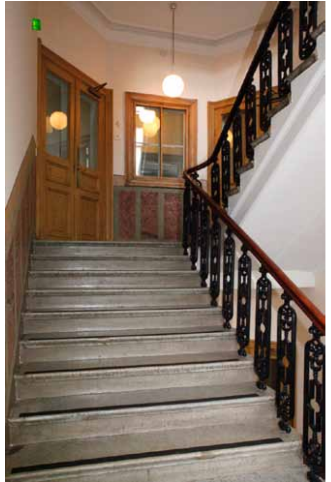
B-portaan välitasanteella on sisäikkuna käytävän puolelle ja viistosti sijoitetut, puiset pariovet. Koristeellinen porraskaiden on alkuperäinen.
