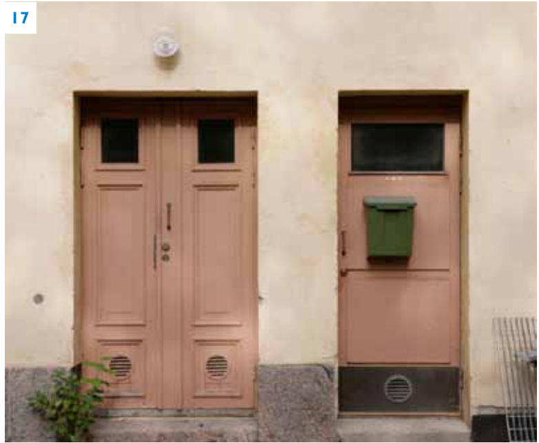
Vasemmalla on B-portaasta sisäpihalle johtava pariovi, oikea ovi johtaa varastoon.
