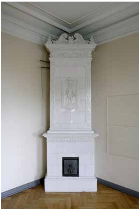
4. kerroksen huoneen 408 kaakeliuuni.
