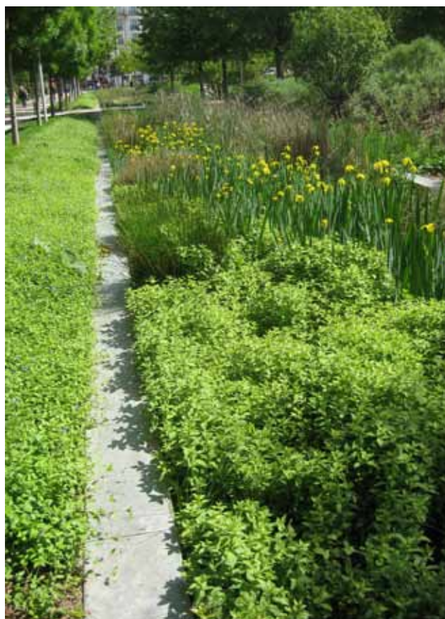
Kuva: Hulevesipainanne kasveineen, N Strengell, Ksv.
