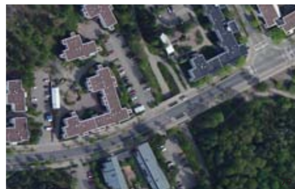
Liittymiskohta: yhteys Haruspuistosta Ison Kallahdenpuistoon
