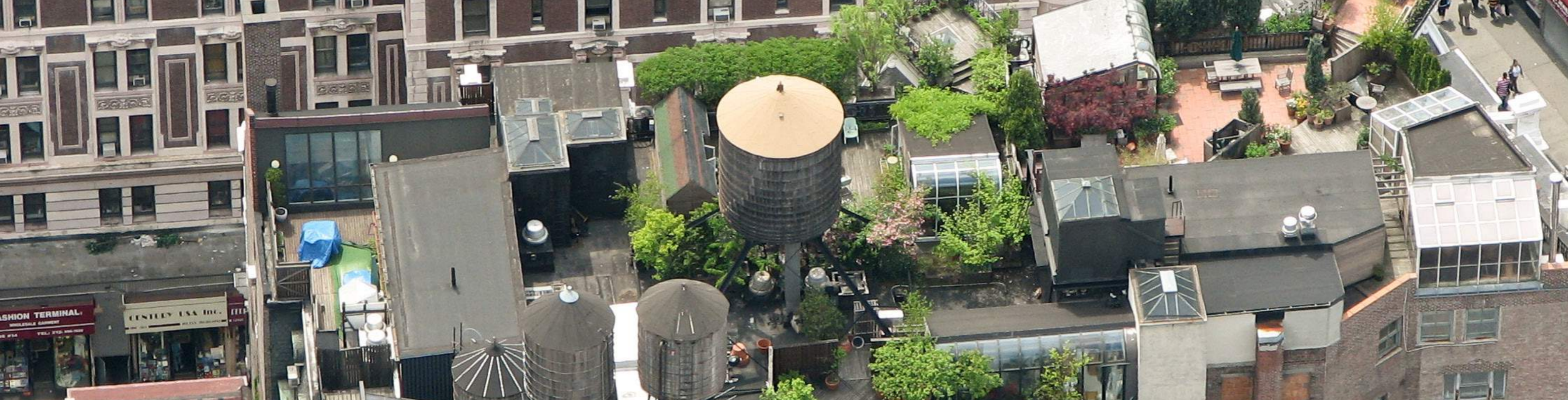
Tiiviissä kaupungissa katot ovat liian arvokkaita, jotta niiden tarjoamia virkistysmahdollisuuksia ei käytettäisi hyväksi. Kuva New York: http://commons.wikimedia.org/wiki/File:New_York_City_view_from_Empire_State_Building_18.jpg
