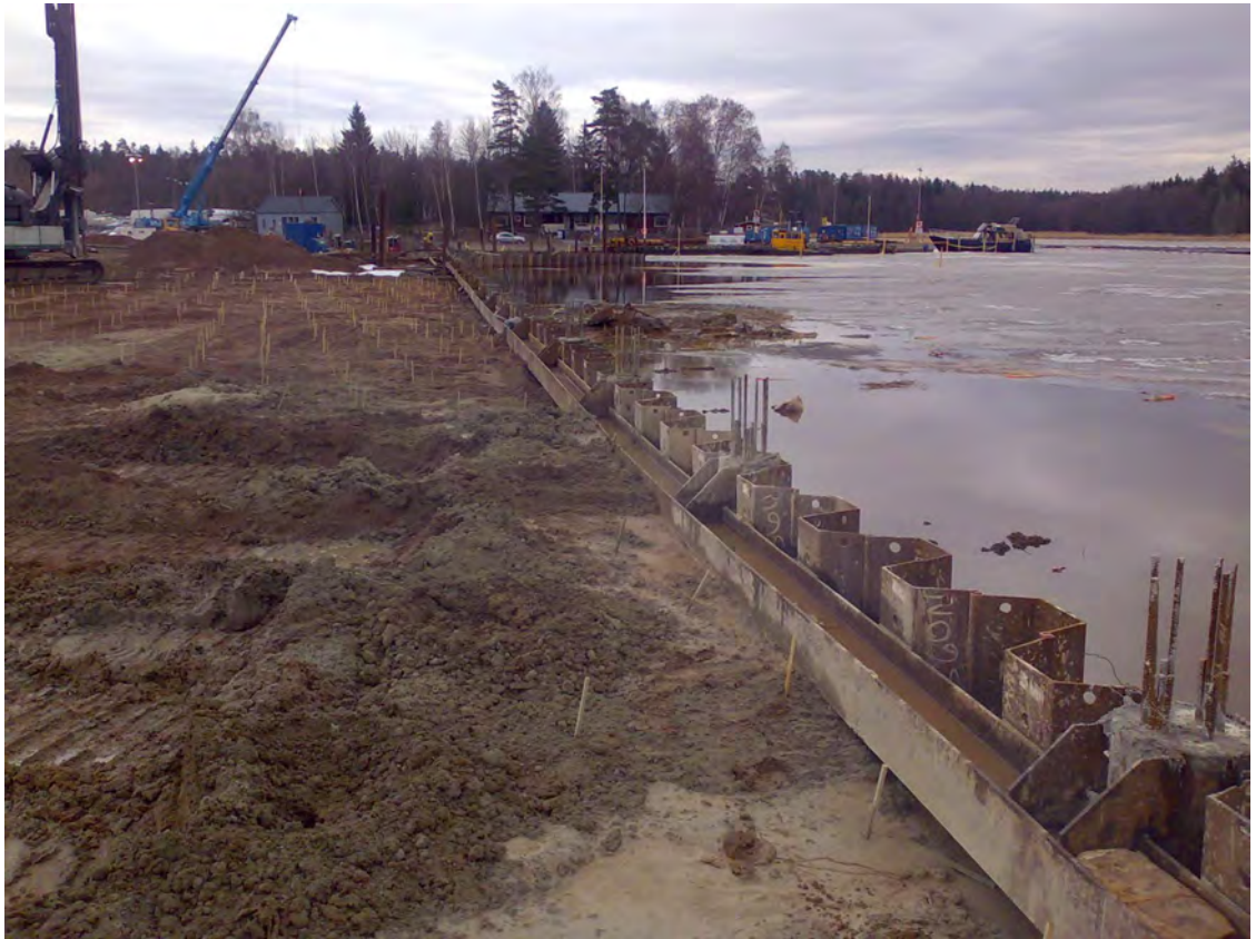
Kuva 9. Paalu-ponttirakenteinen reunamuri Sipoonrannassa. Muurin tausta syvästabiloitiin. (Kuva: Harri Vehmas)
