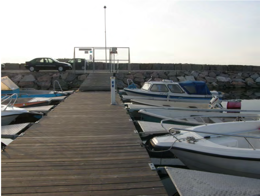
Kuva 11. Svinvikenin purjevenesatamaan rakennetaan ponttoonilaiturit (Kuva: Harri Vehmas)
