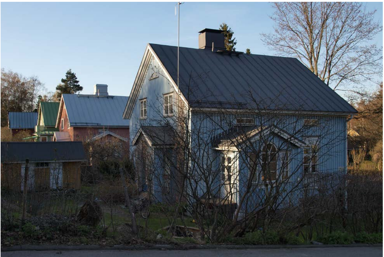
Arkkitehtonisesti arvokkaita, hyvin säilyneitä rakennuksia edellisen aukeaman inventointikartan "punaisella" merkityistä, hyvin säilyneistä kohteista. Marjantatie 28 (yllä) ja Ilmattarentie 10 (alla).
