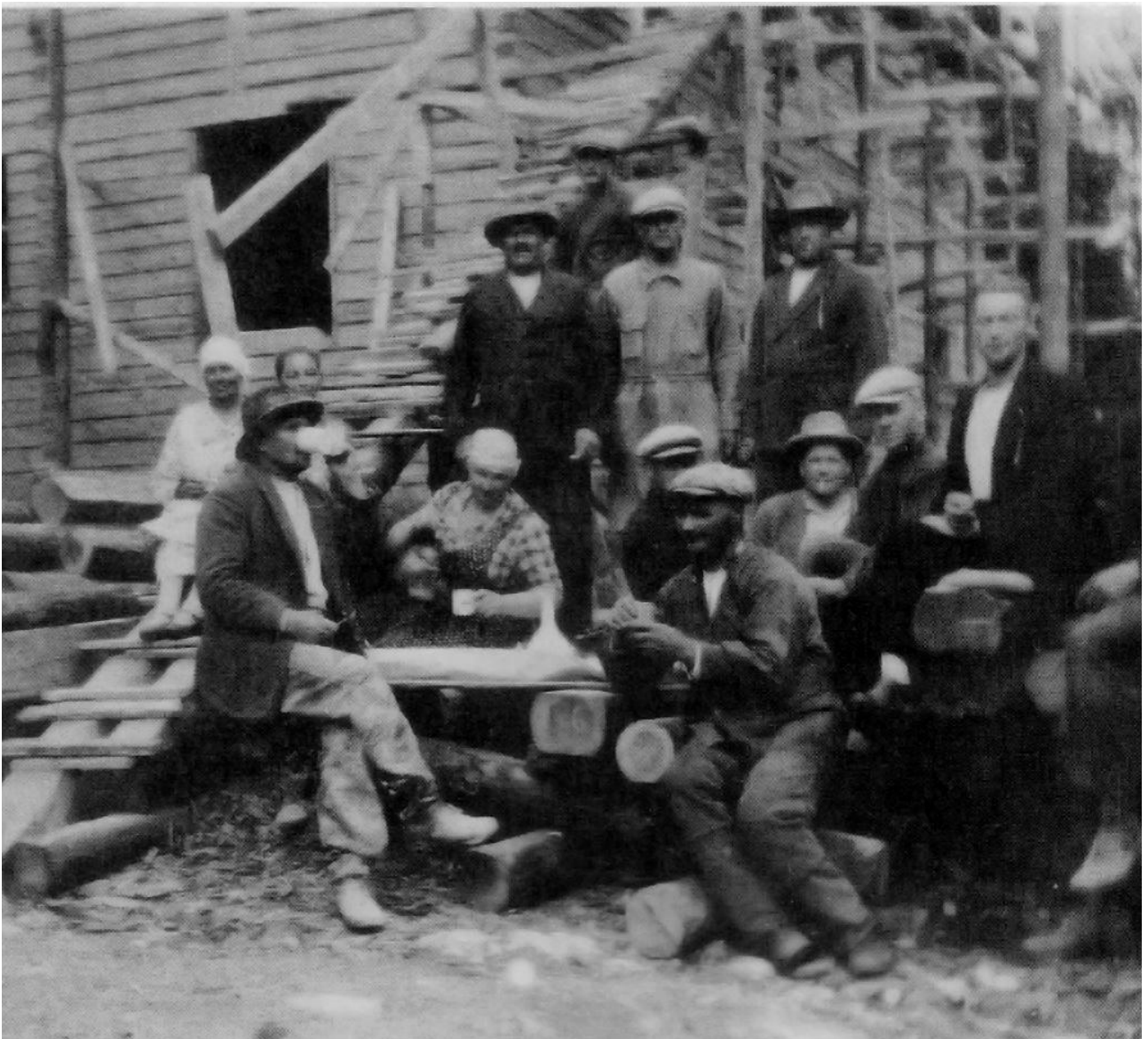
Talkoomiehet tauolla 1920-luvun rakennustyömaalla, mahdollisesti Kumpulassa. HKM
