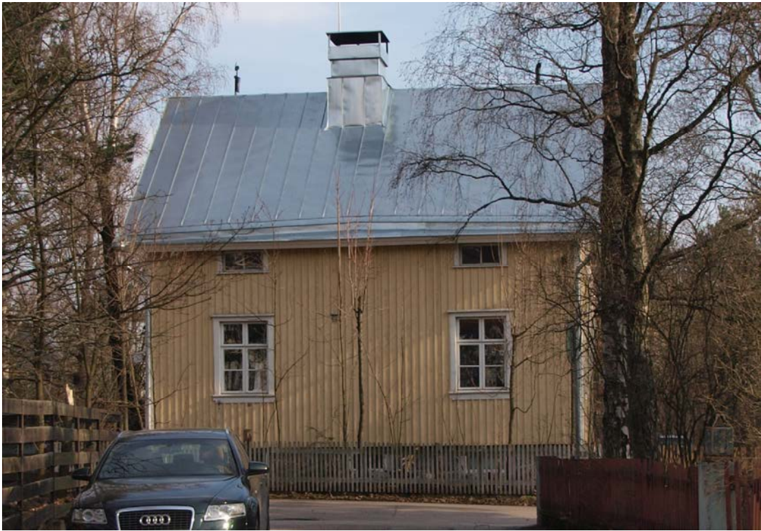
Uusi, saumattu rullapeltikatto jalkaränneineen ja syöksytorveineen on vielä maalaamatta. Huopakatto.
