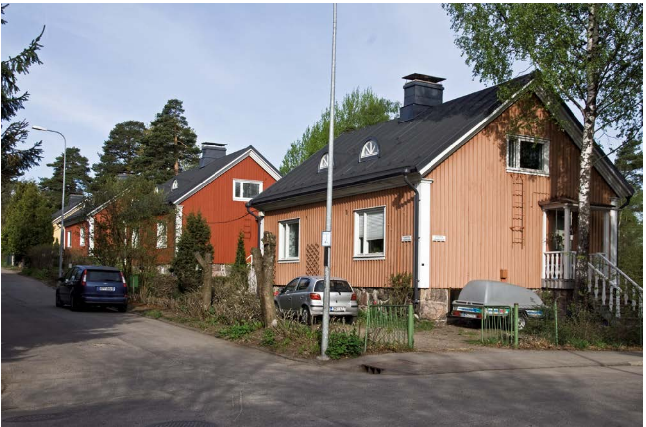
Julkisivumuutosten vaikutus. Muutoksia 1920-luvun lopulta 2010-luvun alkuun Marjatantiellä. Martti Paalasen suunnitteleman taloyhtiön asuinhuoneiden ikkunat on vaihdettu ja kattoikkunoiden määrä on kaksinkertaistunut. Rakennusten mittasuhteet ja julkisivun sommittelun päälinjat ovat kuitenkin ennallaan. Vanha ikkunajako on mahdollista palauttaa. Mustavalkoinen kuva: HKM, kuva 2011 Kari Hakli
