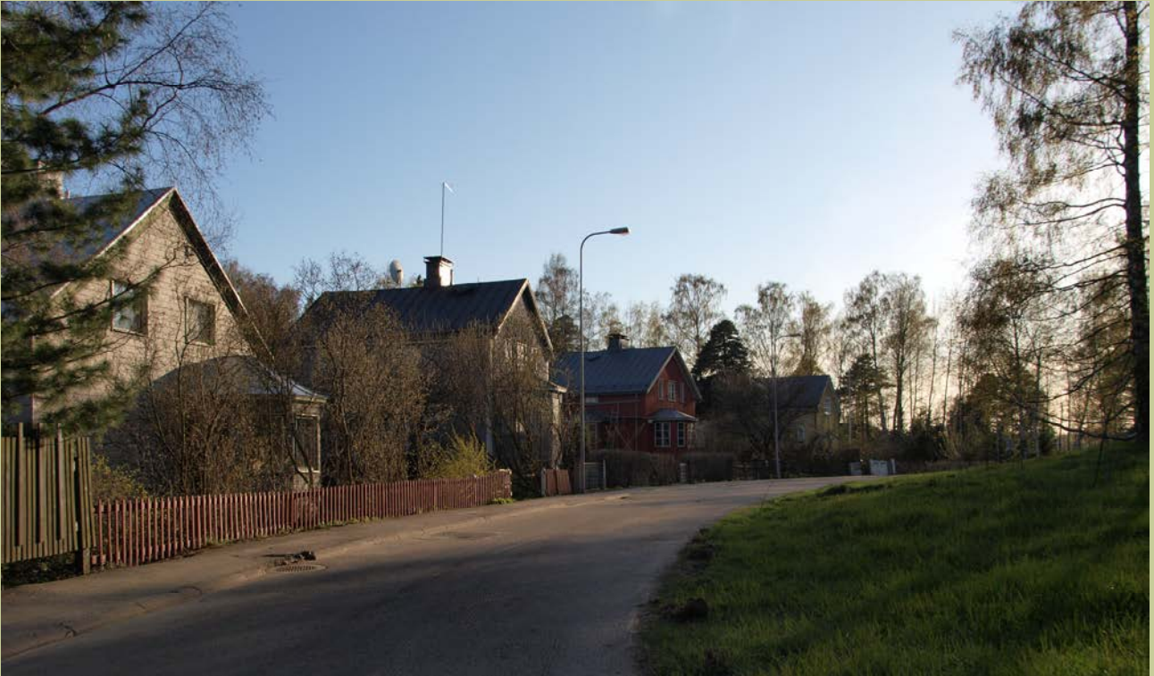
Rauninkujan matalilla, perinteisillä säleaidoilla ja tonttien etuosan istutuksilla on huomattava merkitys katutilan muodostajina ja rajaajina. Oikealla Rauninkallion puistoalue. Rakennukset on sijoitettu säännölliseen riviin, päädyt kadulle päin.
