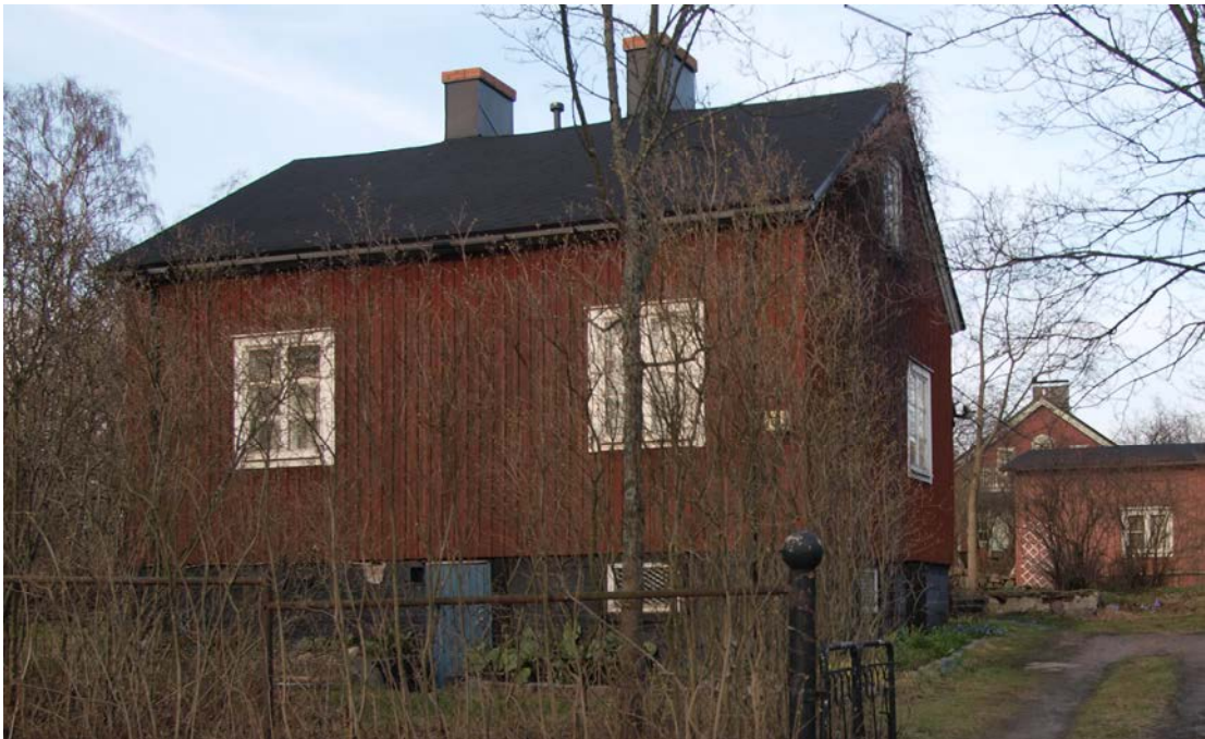
Uusi, saumattu rullapeltikatto jalkaränneineen ja syöksytorveineen on vielä maalaamatta. Huopakatto.
