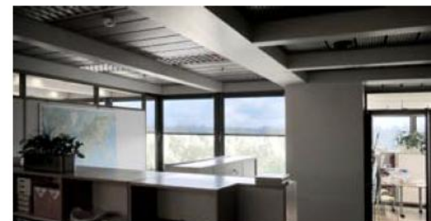
↕↑ Palkiston suunnanmuutos sisäaulan ja ulkoseinän kulmassa. amoy 2013
