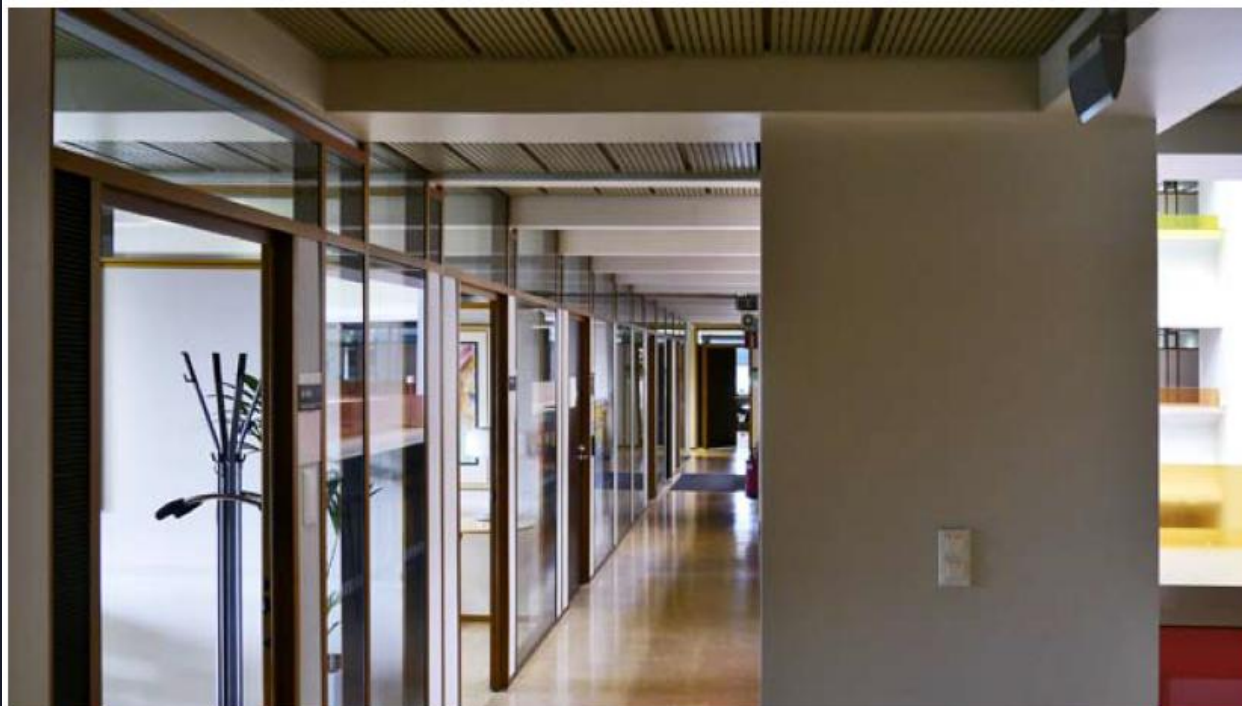
↕↑ Palkiston suunnanmuutos sisäaulan ja ulkoseinän kulmassa. amoy 2013
