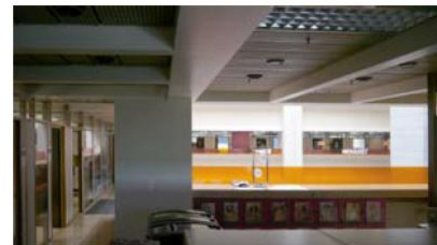
↕↑ Palkiston suunnanmuutos sisäaulan ja ulkoseinän kulmassa. amoy 2013
