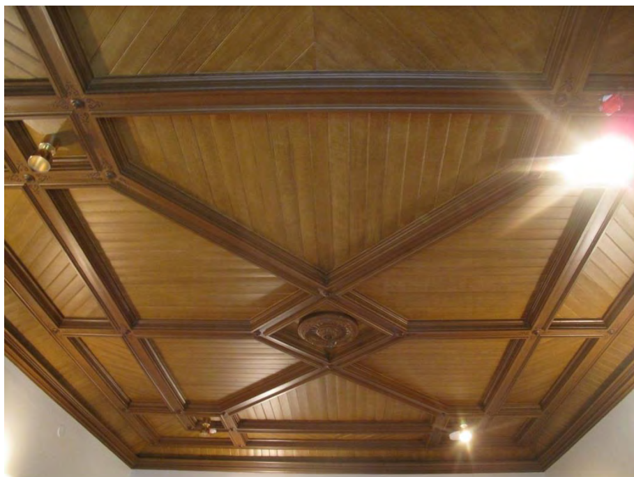
2.krs:n Bulevardi 14 puolelta Sali (217). Puupaneelikatto alkuperäinen Kunnostettu v.1998
