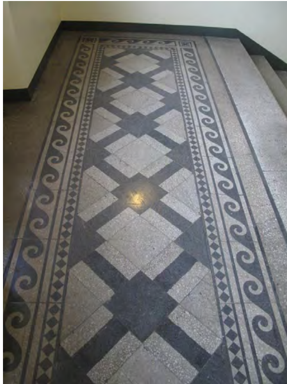
A-portaan alkuperäinen kerrostasolattiamosaikki
