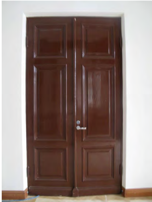
2.krs:n salin (214) alkuperäinen kunnostettu peilipariovi
