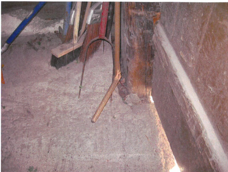
Kuva 5. Osaan varastorakennusta on asennettu betonilattia.
