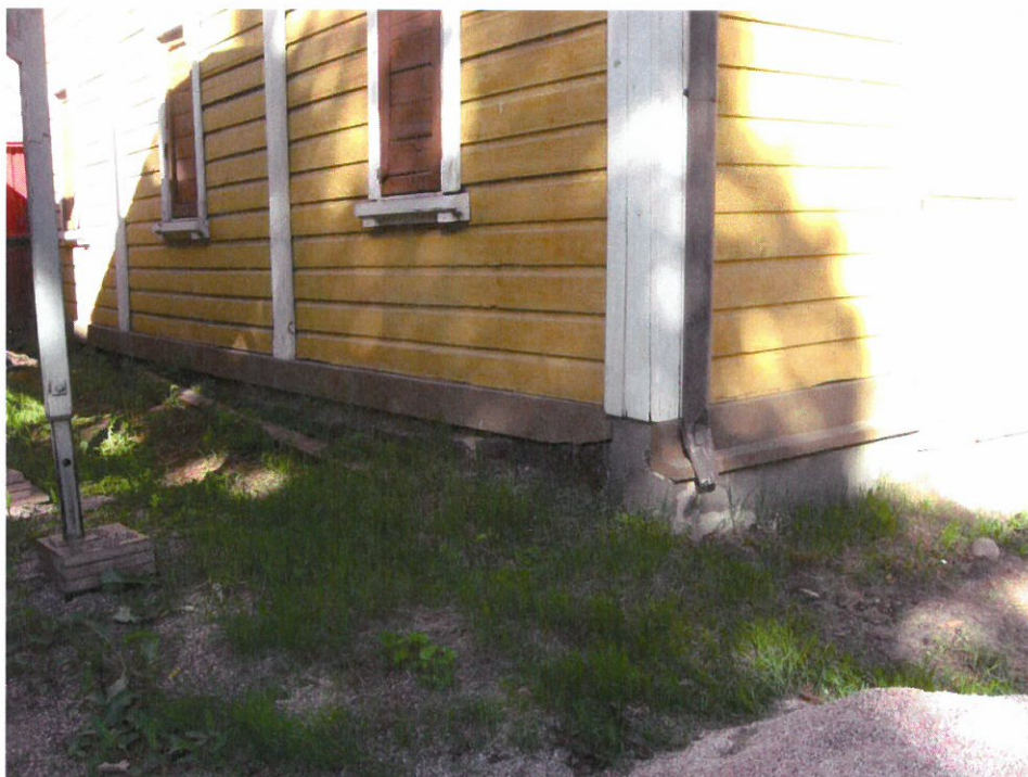
Kuva 2. Varistorakennuksen perustat on suurelta osin uusittu harkkorakenteiksi. Julkisivujen pinnoitukset ja puuosat osin uusittu. Alimpia hirssiä on uusittu.
