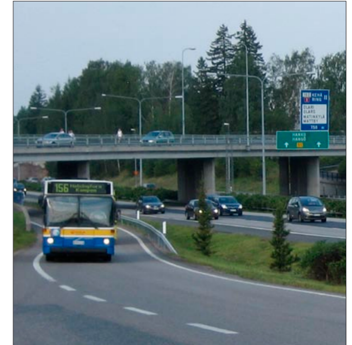
Kuva 70. Länsiväylä Matinkylän kohdalla.
