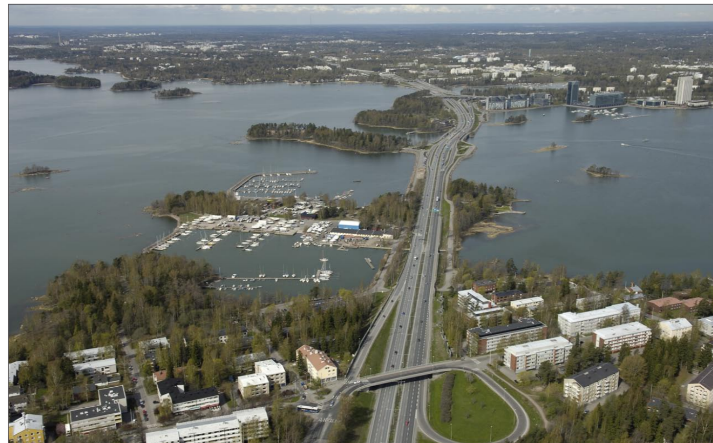
Kuva 67. Ilmakuva Lauttasaaren kohdalta. Länsiväylän eteläpuolella Koivusaaren venesatama ja Hanasaari, pohjoispuolella lahden takana Keilalahden toimistotalot (lähde: Helsingin kaupunkisuunnitteluvirasto).
