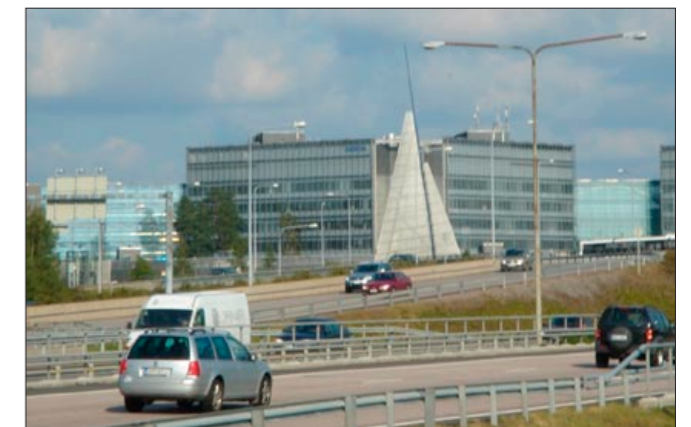
Kuva 68. Otaniemen liittymä Länsiväylällä. Taustalla Keilaniemen toimistotaloja.
