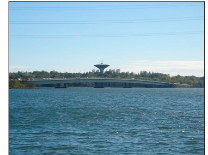
Kuva 65. Lapinlahdensilta Lapinlahdelta katsottuna.
