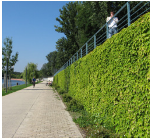
Korkeat tukimuurit verhoillaan köynnöksillä.
