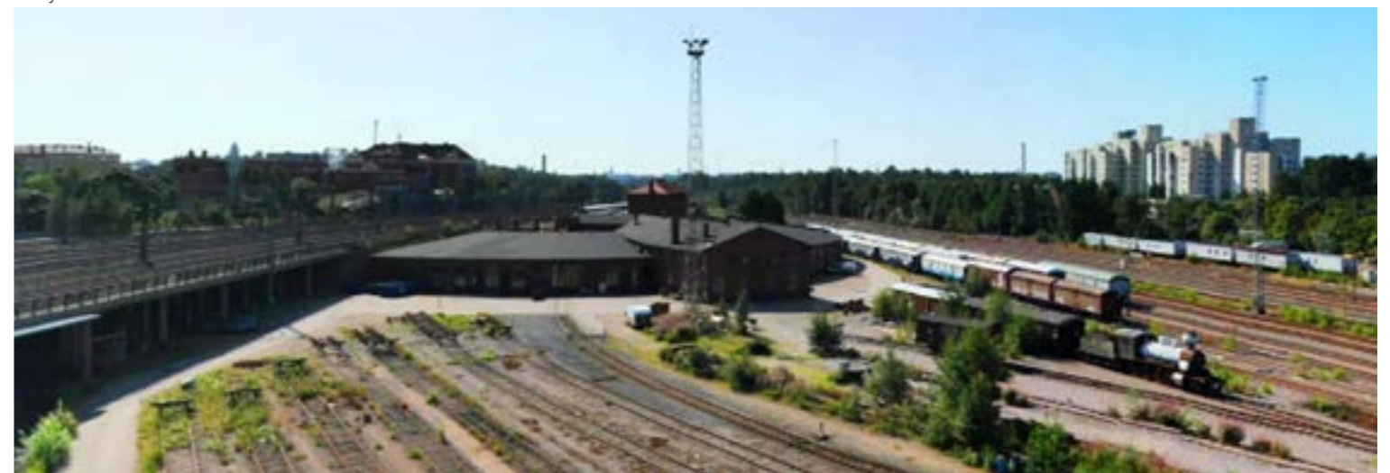
Näkymä etelään - silta
