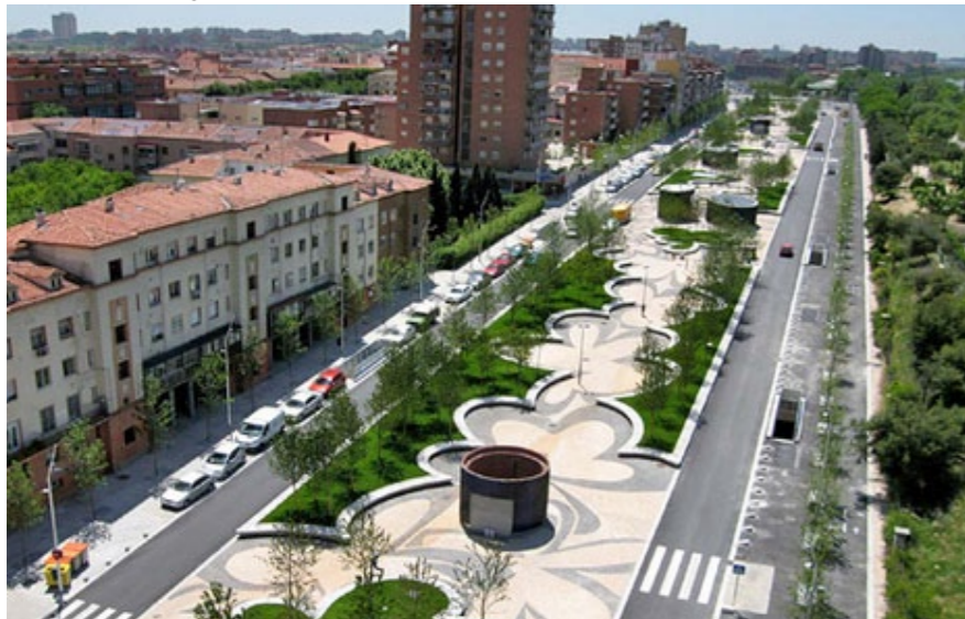
Avenida de Portugal, Madrid
