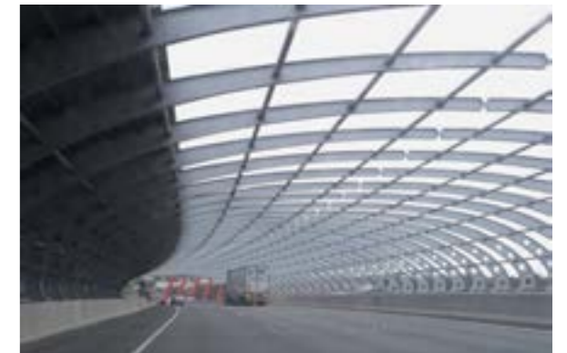
Referenssikuva: esimerkki osittain avonaisesti tunnelirakenteesta.
