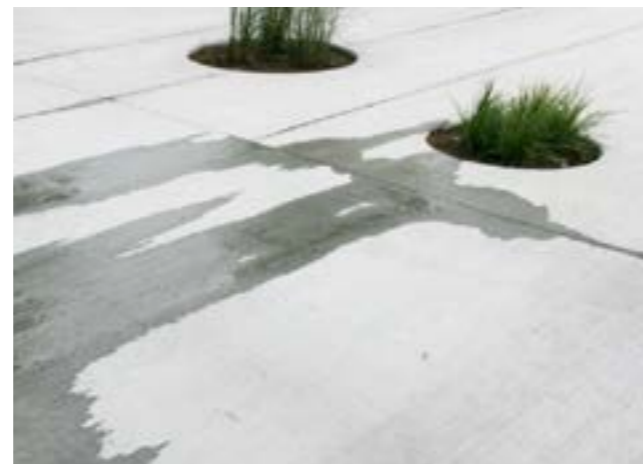
Harjattu vaalea betonipinta
