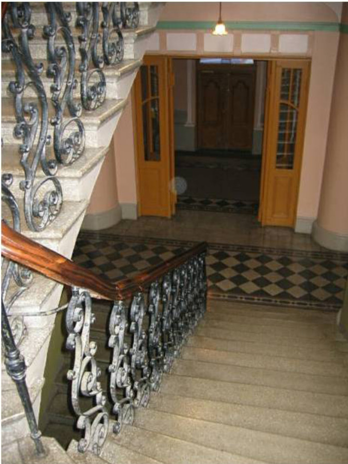
Porrashuone ennen hissin asentamista
