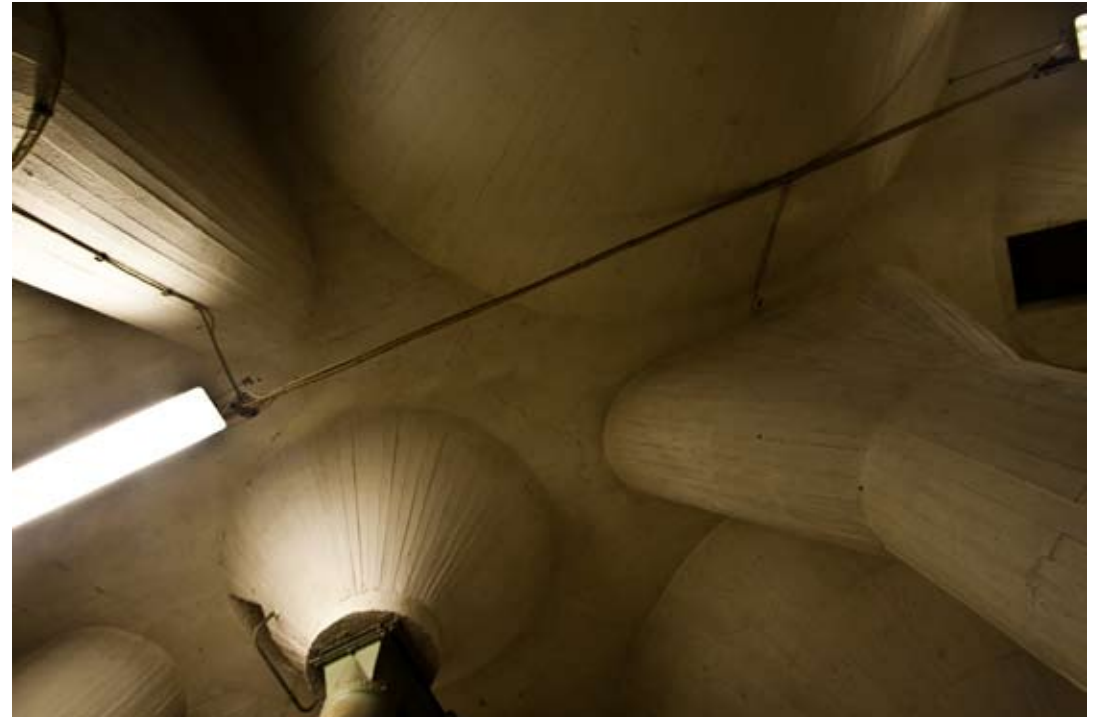
Kuva 6.18 Siilokellarin kattoa. Kuva MN / Talli
