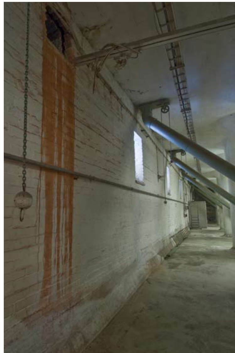
Kuvat 6.16- 6.17 Siilokellarin sienipilareita ja kuljettimia. Kuvat MN / Talli
