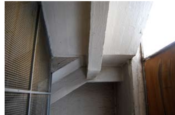
Kuva 6.20 (yllä). Konteronin portaan betoniaskelmia.
