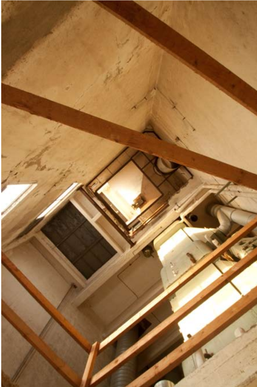
Kuvat 6.43 (vasemmalla), 6-44-6.45 (yllä) Konetomin 6. kerroksesta on purettu osa välipohjaa, tila on avoin kahteen ylempään kerrokseen. Kuudenteen kerrokseen sijoittuu käytöstä poistettu kuivuri. Valokuvat Talli / MN.
