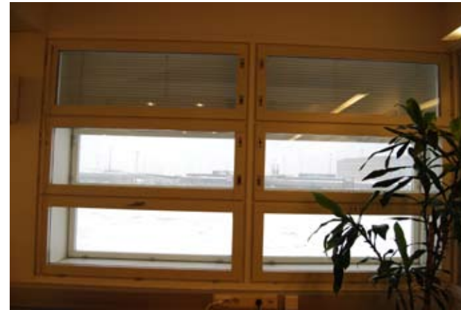
Kuva 6.97 (vasemmalla) Tasovaraston toimistotiloille tyypillinen ikkunarakenne 1980-luvulta.
