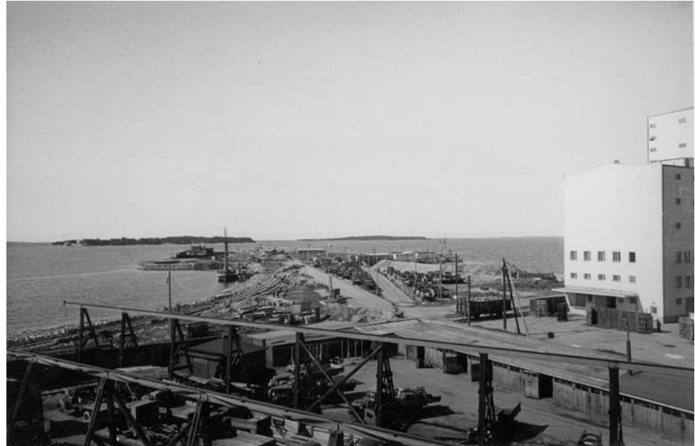
Kuva 2.4 Rakennuspaikka ennen tehtaan varsinaisten rakennustöiden aloittamista. Kuvassa oikealla vuonna 1936 valmistunut Munkkisaaren Mylly, jonka osti vuotta myöhemmin Vaasan Höyrymylly Oy. MOBA
