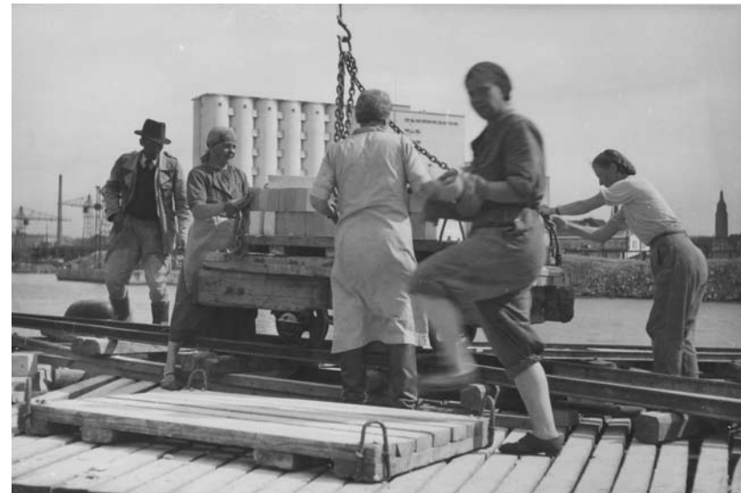
Kuva 3.9 Naisia rakennustöissä tehtaan työmaalla. MOBA
