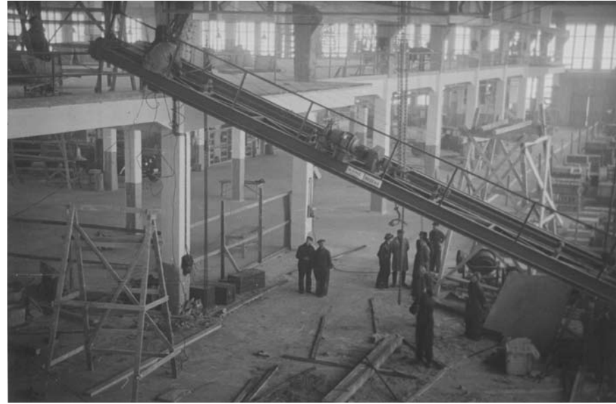
Kuva 3.11 Siltanosturia asennetaan paikalleen. MOBA.
