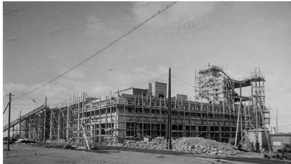
Kuva 3.8 Tehtaan työmaa. Torni nousee. FORD
