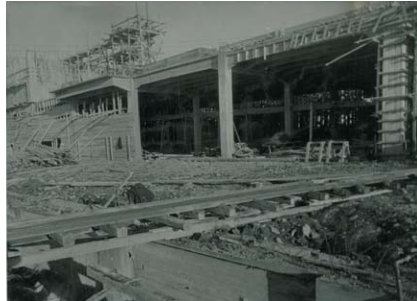
Kuva 3.6 Rakennuksen runko nousee. Tehdashallin keskiosan välipohja ja pilarit kuoriutu- vat lautamuoteista. MOBA
