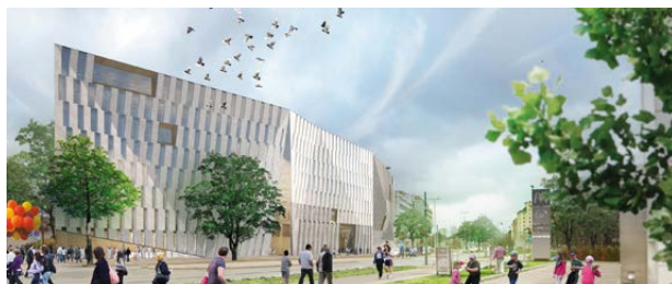
Teollisuuskadun varsi täydentyi. Kuva: JKMM Arkkitehdit Oy
