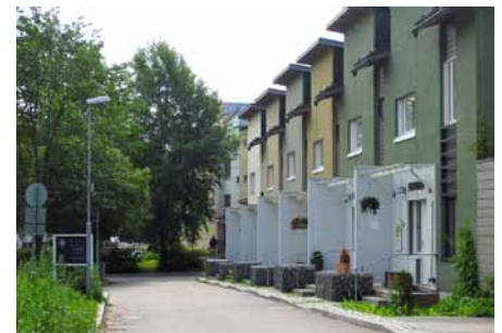
Uutta rakentamista Jakomäessä.
