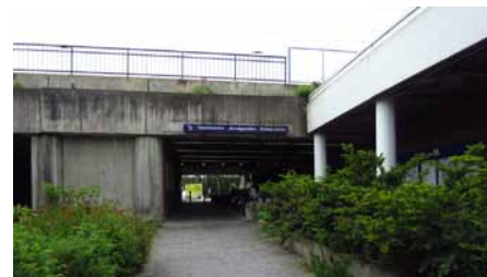
Pukinmäen aseman sisäänkäynti pyöräpysäköinteen
