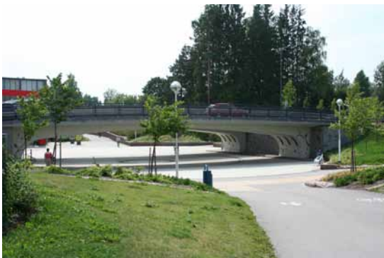
Keravan Sibeliuksen tien alikulku esimerkkinä avarasta kevyen liikenteen alikulusta.
