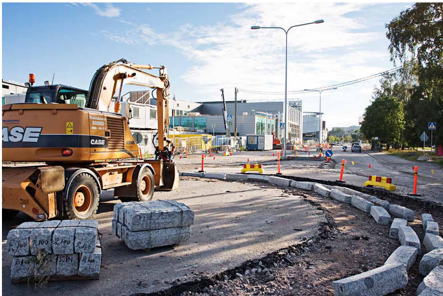
Kuva Itäkeskuksen katutöistä 2010, kuva Simo Karisalo
