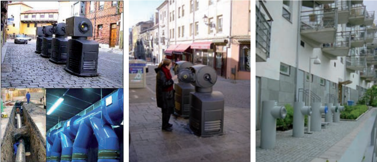
Kuvat 16–20. Esimerkkejä imutyhjennykseen perustuvista jätehuoltoputkijärjestelmistä, vasemmalla ja keskellä León, Espanja (Lahti et al. 2006, s. 212–214), oikealla Hammarby, Tukholma, Ruotsi (kuvat P. Lahti 2004).
