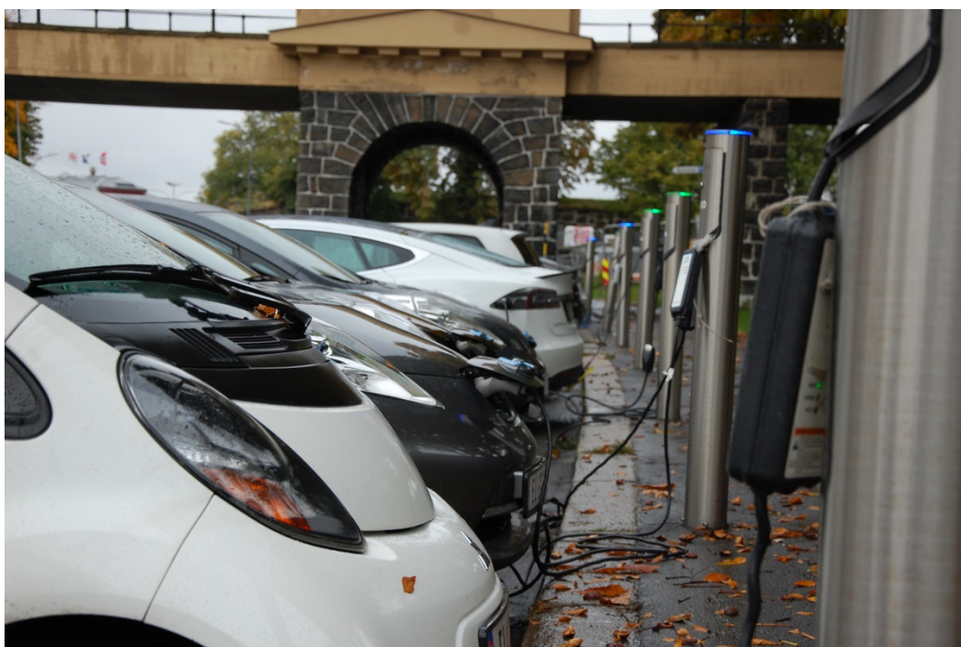
Kuva 5. Pysäköintialue Oslossa, jossa on sijoitettu useita sähköautojen latauspisteitä vierekkäin (Kuva: Sito Oy 2015).
