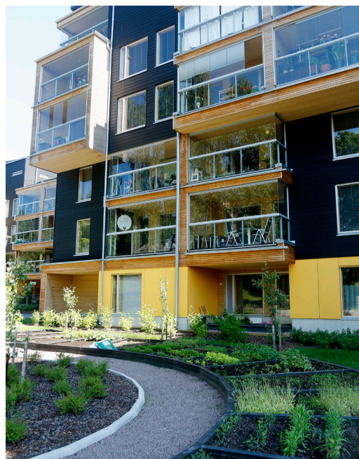
Puukerrostalorakentamista Eskolantiellä Pukinmäessä.
