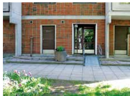
19. Kiinteistöt ovat pyrkineet ratkaisemaan painumisesta aiheutuneita ongelmia väliaikaisennäköisillä ratkaisuilla.
