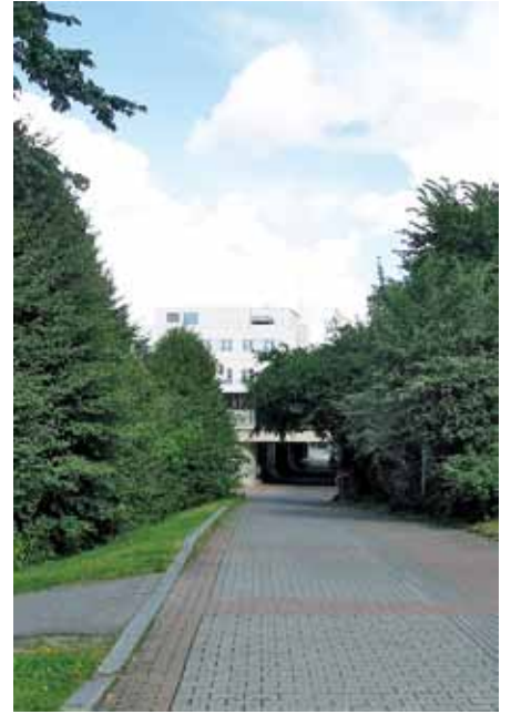
49. Latokartanontien alikulku on pimeä. Ylitiheä ja korkea, varjostava kasvillisuus lisää turvattomuuden tunnetta.
