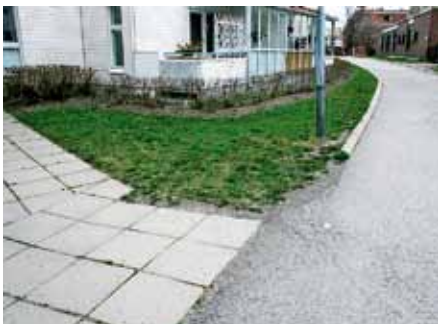
39. Soidintie 8. Tontin puolella reunakiveä ei ole ja kadun reunakivestäkin osa puuttuu.
