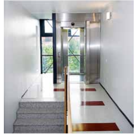
62. Hissi voidaan jälkiasentaa myös vanhaan porrashuoneeseen.
