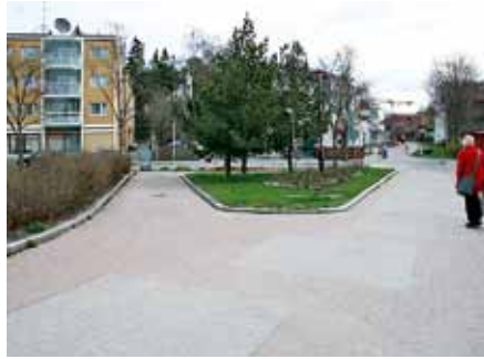
26. Pekanraitin ja Soidintien risteysalueella vesiputket korjataan.
