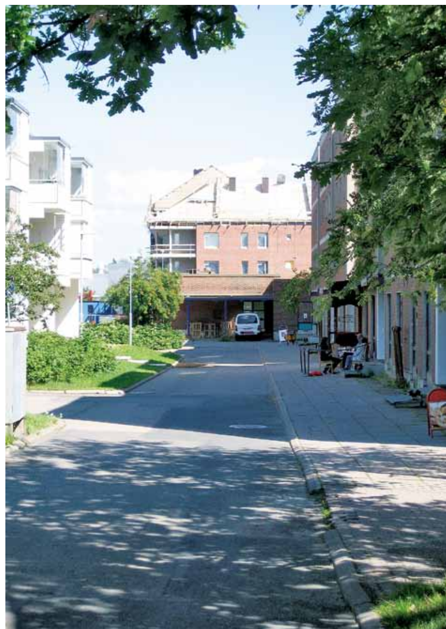
94. Pekanraitin loppuosa ei hahmotu jalankulkuraitiksi. Betonilaatoilla päällystetty jalkakäytäväksi hahmottuva osa on kiinteistön tontilla.
