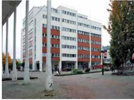
23. Ala-Malmin torilla sijaitsevan Malmin virastotalon julkisivut on korjattu kesällä 2012.
