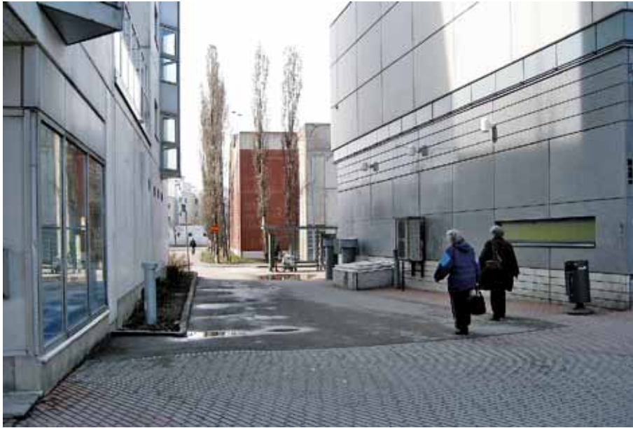
72. Pikkalankadulta torille johtavalla kujanteella tulisi talotekniset laitteet peittää näkyvistä korkealaatuisella tavalla. Takapihamainen ilme ei sovellu vilkkaan kävelyreitit varrelle eikä kauppakeskuksen käyntikortiksi. Torin betonikiveyksen jatkaminen kujalle liittäisi sen paremmin osaksi torin kokonaisuutta.
