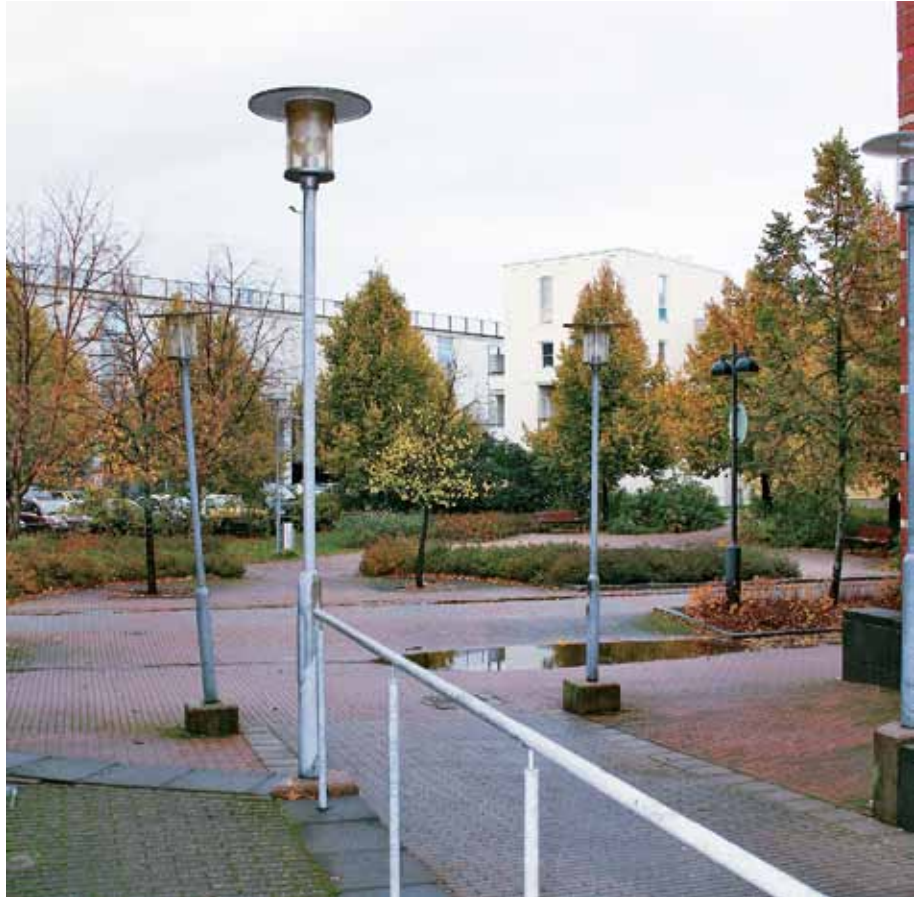
45. Seurakuntatalon kohdalla Pekanraitilla on kolmea erilaista valaisintyyppiä hyvin lähellä toisiaan. Osa valaisimista on myös kallistunut. Lopputulos ei muodosta yhtenäistä kokonaisuutta. Raitin osalta valaisimet tulisi yhtenäistää. Etualan valaisin kuuluu Ala-Malmin puiston kokonaisuuteen joka tulisi säilyttää.
