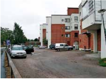
22. As oy Ormusmäentie on aloittamassa Teerisuontien puoleisen pihan peruskorjausta.
