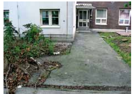
84. Pekankatu 5. Hoitamattomuus lisää ilkeävaltaa ja turvallisuutta.
