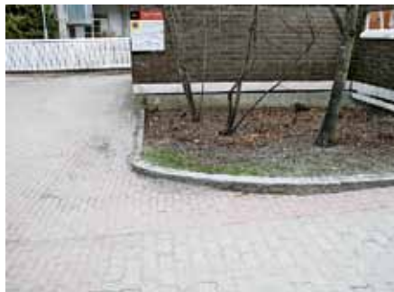
37. Pekankatu 5. Tontinpuolella reunakivi on betonia ja katualueella graniittia. Istutusalueella ei kenttäkiveystä.
