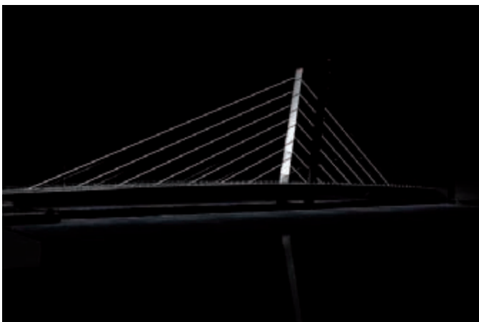
Ruoholahden kanavan ylittävä Crusellinsilta suunnitellussa yövalaistuksessa.
