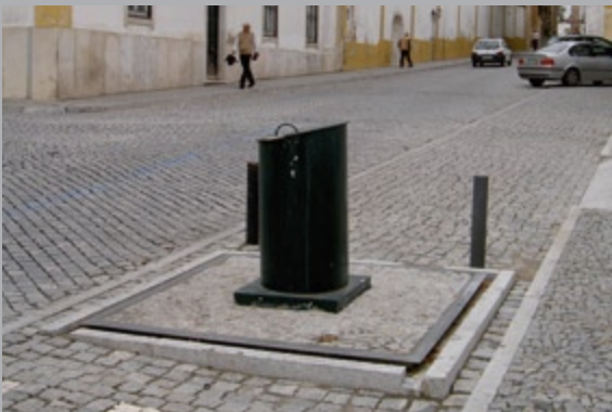
Jätessäiliö voidaan sijoittaa myös kadun alle. Portugali.
