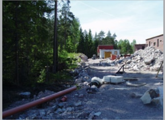
Metsään on louhittu katulinja Latokartanossa, seuraavaksi on vasemmalla olevan tontin vuoro: kadun kulmaan tulee rakennus. Viikki.
