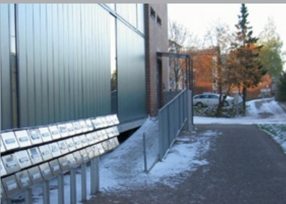
Kattamaton sisäänkäyntiluiska muodostaa pituutensa vuoksi kilpailvan reitin pihakäytävän kanssa. Malmi.
