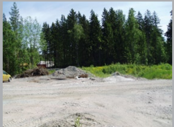
Puusto on kaadettu esirakentamisen tieltä. Pihasuunnittelun haasteena on istuttaa tontti uudelleen murskepatjan päälle. Viikki.
