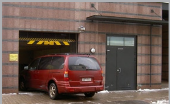
Pysäköintihallin suuaukko ilman rampia asettuu osaksi pohjakerroksen julkisivua. Vuosaari.
