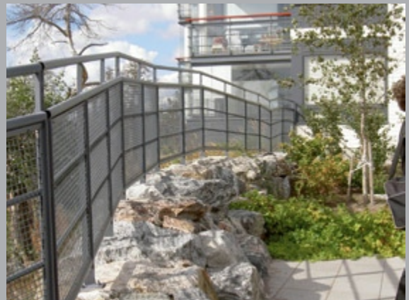
Pihaan rakentaminen jyrkkään maastoon vaatii usein putoamisesteitä. Viikinmäki.
