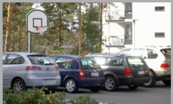
Pelastuspaikkojen mittakaava johtaa virheellisiin tulkintoihin: pelastuspaikalle on määräysten vastaisesti pysäköity autoja eikä pelastuspaikkaa tai koripallotelinettä voida käyttää. Viikinmäki.
