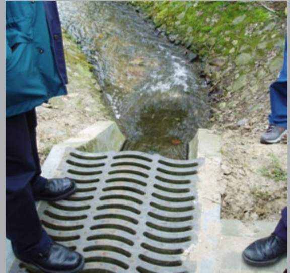
Hulevedet kerätään avuomaan Hollannissa. Puro alittaa kulkutiet ritilärakenteissa, jolloin ojat toimivat myös ekologisina käytävinä. Ratkaisu myös lisää haihduntaa.
