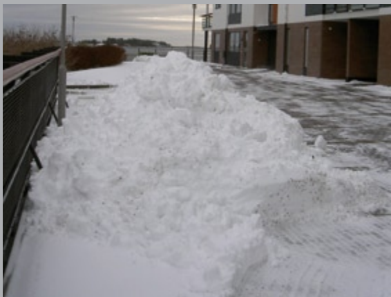
Lumitilan sijoittaminen kannelle aiheuttaa kannen kaivoille kuormitusta lumen sulaessa ja tulvan, jos kaivot ovat tukossa. Vuosaari.
