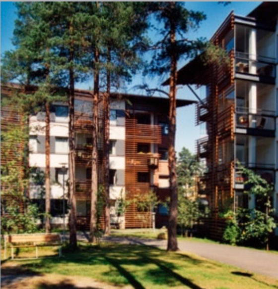
Poutamäessä rakennuttajan panostus suunnitteluun ja toteutukseen sekä pyrkimys laadukkaaseen lopputulokseen näkyy ympäristössä. Pajamäki.
