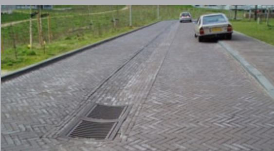
Hulevedet kerätään pihakadun keskellä. Uoma toimii samalla ajohidasteena. Hollanti.
