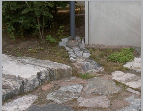
Kattovedet johdetaan läpäiseville pinnoille. Viikinnäki.
