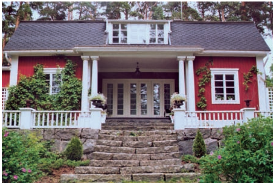
Sandbackan kunnostettu huvila, säilytettävät kivirakenteet.
