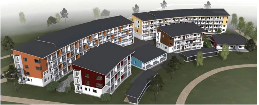
I Hongasmossa bostadsområde har träbyggande kombinerats med hög energieffektivitet.
