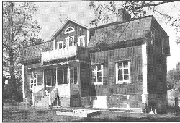
Asuinrakennus Kivihaantie 15 vuodelta 1929. Kaupunkikuvallisen arvonsa takia suojeltu rakennus (sr-1).
