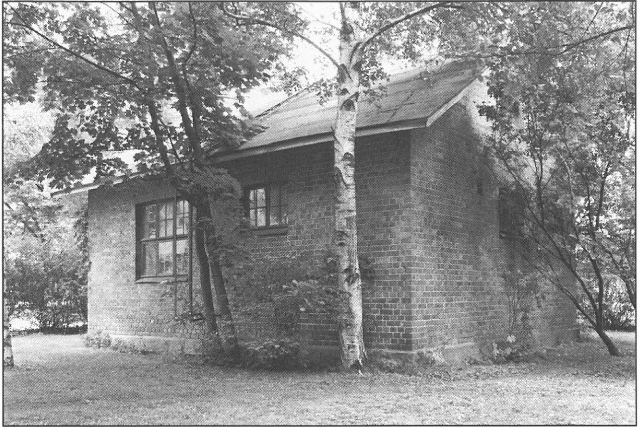
Pesula, Huopalahden aseman rakennuksia Kylätie 25.
