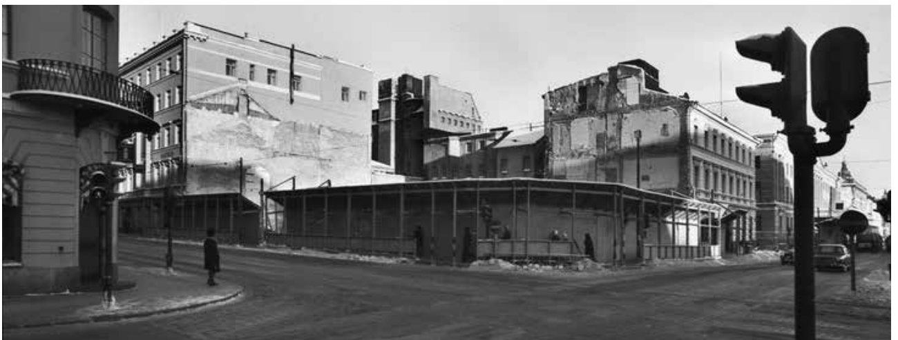
Pohjoisesplanadi 17 purettuna 1970. Simo Rista HKM.
