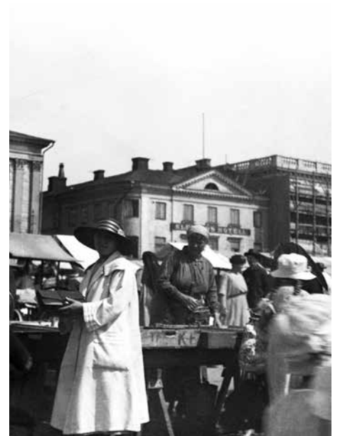
Helsinkiläistä torielämää noin 1924, kun suurlähetystön rakennustyö on käynnissä. Hjalmar Henriksson HKM N112263
