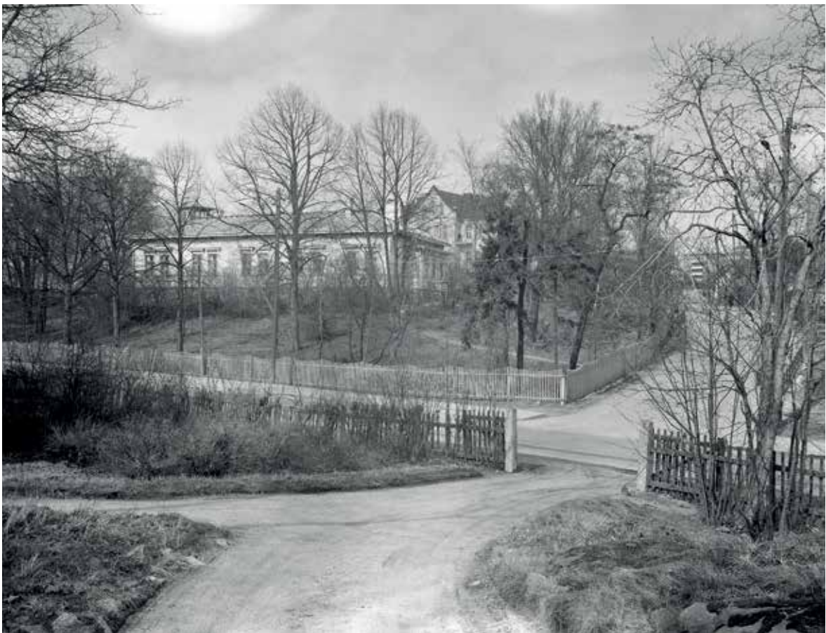
Tontin 7 1890-luvun puurakennus nähtynä huvila 13 pihalta. Välissä kulkee Eläintarhantie
