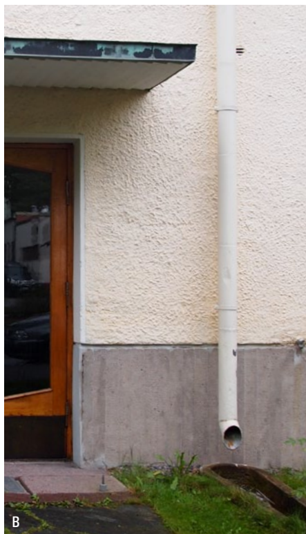
A. Kisakylän pihakäytävät olivat alunperin hiekka- tai sorapintaisia. Arkkitehtuurimuseo. B. Rännien alla tulisi käyttää betonista kourua. C. Pihan luontaisiin painanteisiin tulisi lisätä imeytymisalueet. D. Asfaltoituja pihakäytäviä tulisi palauttaa sorapintaisiksi.
