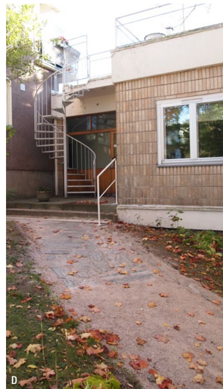
A. Kisakylän pihakäytävät olivat alunperin hiekka- tai sorapintaisia. Arkkitehtuurimuseo. B. Rännien alla tulisi käyttää betonista kourua. C. Pihan luontaisiin painanteisiin tulisi lisätä imeytymisalueet. D. Asfaltoituja pihakäytäviä tulisi palauttaa sorapintaisiksi.
