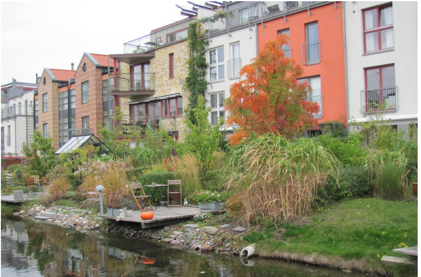
Kuva 62. Hulevedet johdetaan rakennusten pihoja rajaavaan hulevesiaiheeseen. Malmön asuntomessualue. Kuva: Mervi Nicklén
