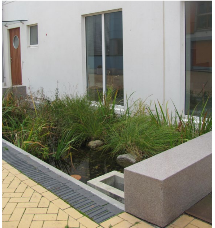
Kuva 64. Hulevesien käsittelyä katualueella. Malmön asuntomessualue. Kuva: Mervi Nicklén
