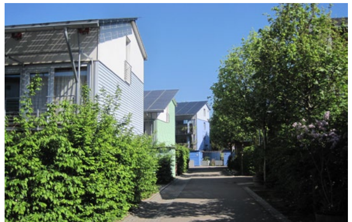
Esimerkki aurinkopaneelien integroimisesta harjakattoon. Freiburg, Saksa.
