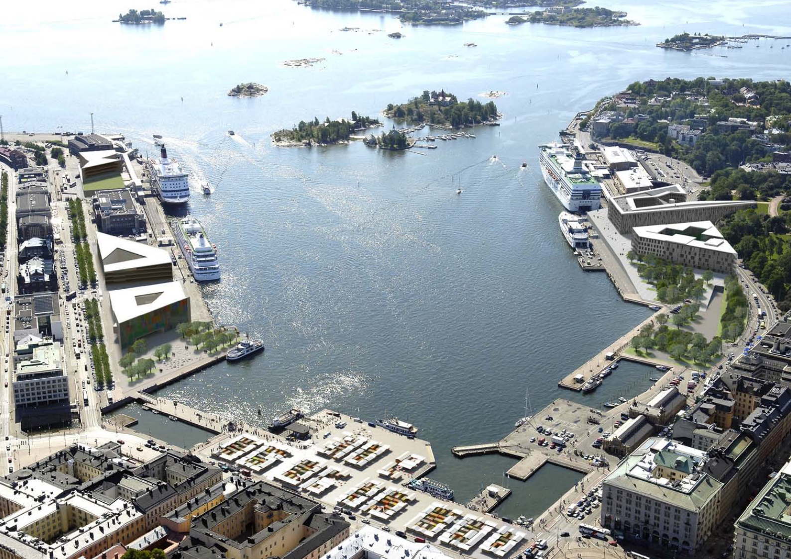
Tori, aerial view Tori, ilmakuva
