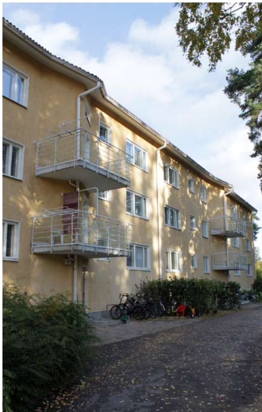
Saunarakennus on tyyliltään funktionalismin sävyttämää klassismia.
