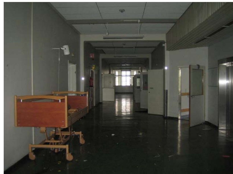
Potilashuoneiden jakaminen väliseinillä ei ole mahdollista ikkunajakoa muuttamatta.
