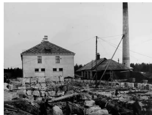
B-paviljongin rakennustyöt käynnissä. (HKM)
