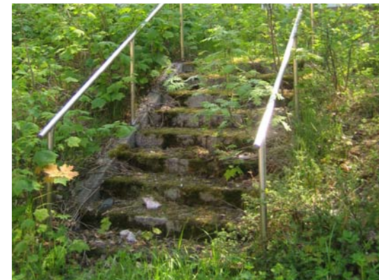
Hallintorakennuksen viereiselle kalliolle johtaa edelleen portaat.
