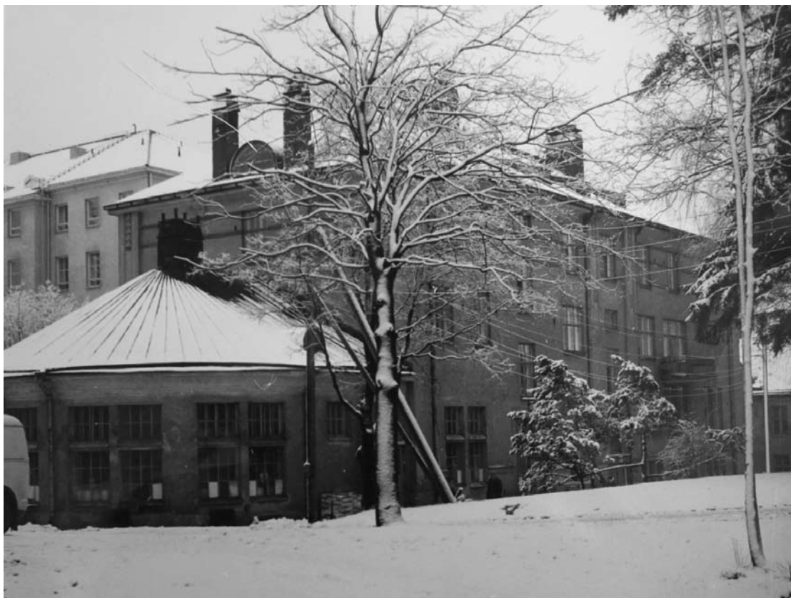
Vanha keskusrakennus vuonna 1960 juuri ennen purkamista. (HKM)
