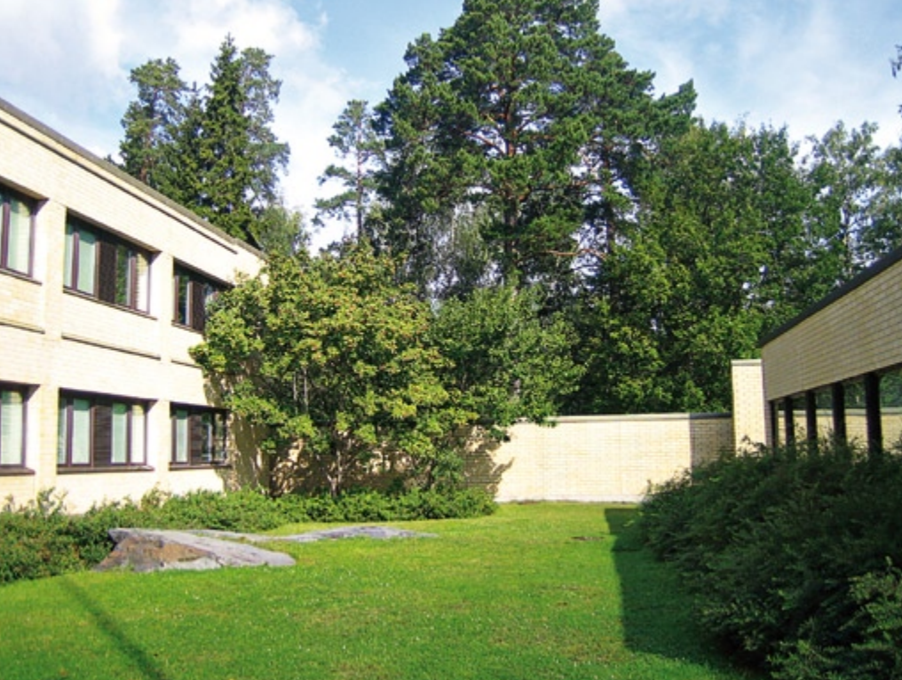
Palvelutalon, ryhmäkodin ja seurakuntatalon pihat yhdistetään yhdeksi korttelipihaksi purkamalla kuvassa taka-alalla näkyvä tiilimuuri.
