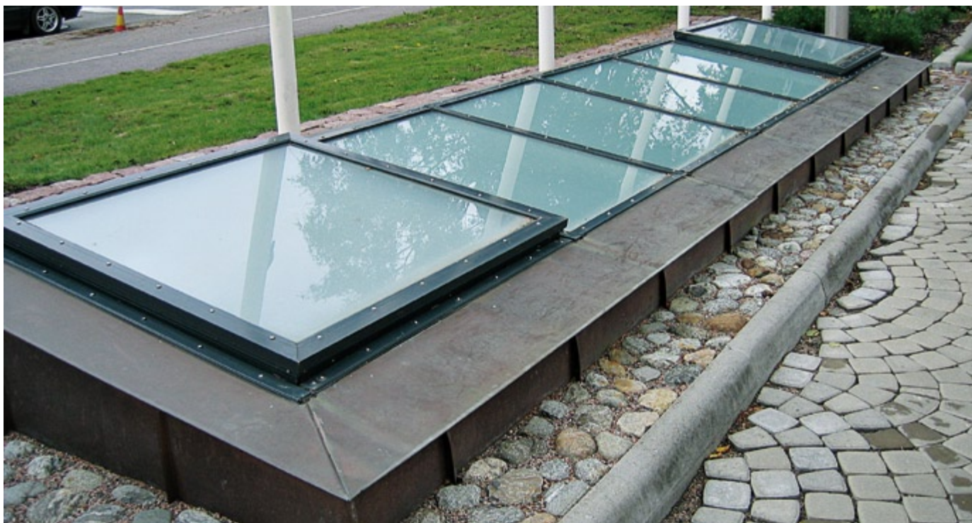
Autohalleihin saadaan luonnonvaloa lasikatteisista valoaukoista, jotka toimivat myös savunpoistoluukkuina.
