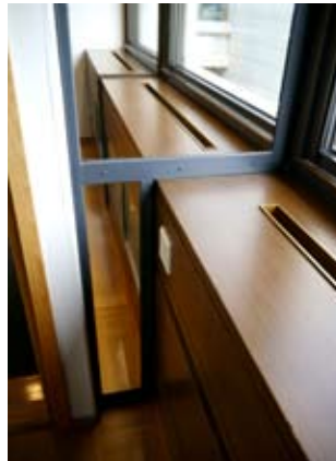
↑ Ikkunapenkkeihin liittyy ilmanvaihdon sekoitusyksikkö ja sekoitetun ilman jakokanavat. Kuva rakennusvaiheesta. LVI-Pohjolassa s. 37 ↗ Jakokanavan alapuolinen osa on käytetty kaappitilana siellä, missä ei ole sekoitusyksikköä. 10. krs:ssa kaapin ovet on vaihdettu lasiksi. amoy 2013
