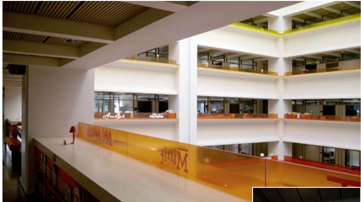
↑ ↓ Tiheä sekundääripalkisto 6. kerroksen sisäaulaa kiertävältä käytävältä. amoy 2013 → Näkymä 10.kerroksen käytävältä. amoy 2013
