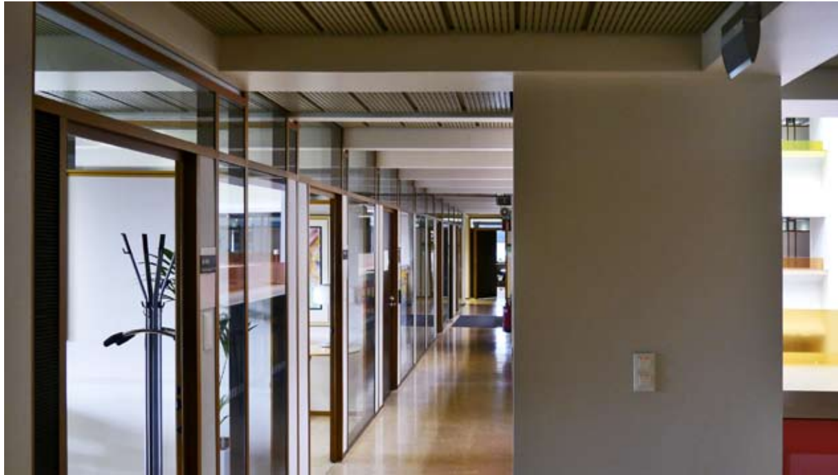
↓↑ Palkiston suunnanmuutos sisääulun ja ulkoseinän kulmassa. amoy 2013
