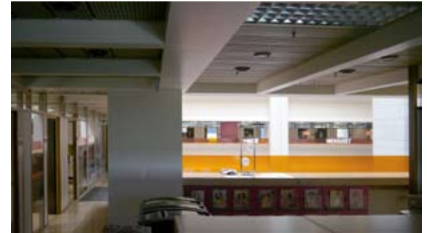
↓↑ Palkiston suunnanmuutos sisääulun ja ulkoseinän kulmassa. amoy 2013
