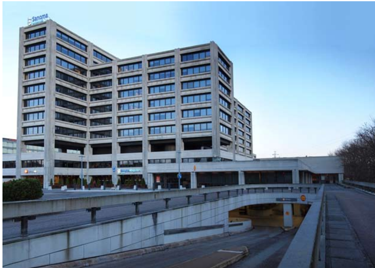
↑ Näkymä autoliikenteen pääsisäänkäynnin kohdalta kohti A-tornia. amoy 2013
