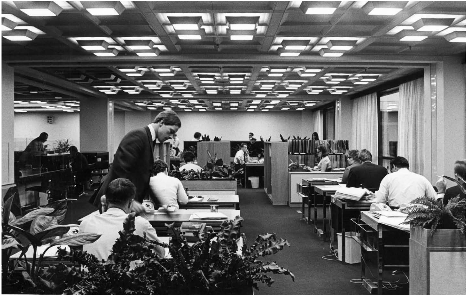
↑ Kaksoisprimääripalkiston luomaa avokonttoritilaa alkuperäisvaiheen jalustaosassa. Pohjolan toimitalo, Arkkitehti-lehden esittelyaineisto, kuvat Risto Kamunen ja Matti Saanio. AmA
