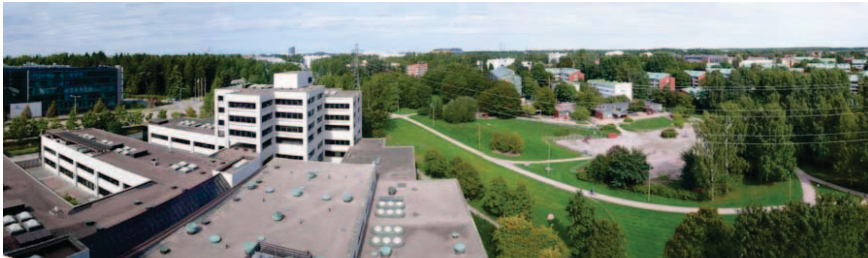
↑ Kuva rakennuksen katolta luoteeseen. Vasemmalla Huopalahdentie ja sen toisella puolella toimistotalo vuodelta 2002. Kauempana siintää 18-kerroksinen Pitäjänmäki Tower. Oikealla Kultareunan asuinalue. amoy 2013
