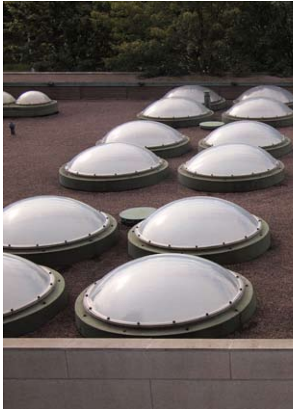
↖ ↑ Alkuperäisvaiheen kattoikkunoita päältä päin kuvattuna. Vasemmalla kolmikupuinen soikea kattoikkuna, keskellä kirjapainosalin suuret pyöreät kattokuvut ja oikealla pääaulan valokattoa. Viimeksimainitut on hiljattain uusittu entisen kaltaisina. amoy 2013
