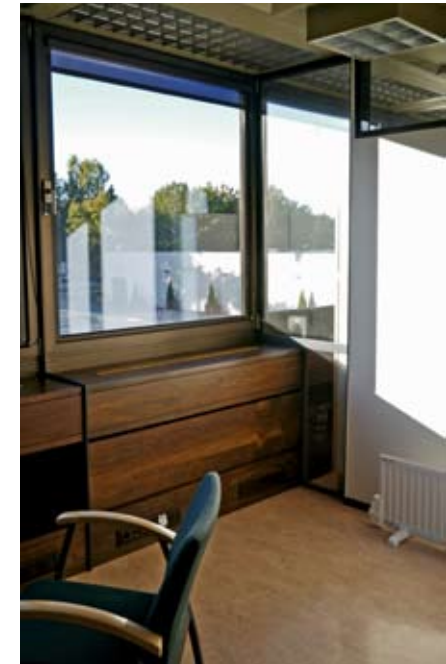
↑ Ikkunapenkkeihin liittyy ilmanvaihdon sekoitusyksikkö ja sekoitetun ilman jakokanavat. Kuva rakennusvaiheesta. LVI-Pohjolassa s. 37 ↗ Jakokanavan alapuolinen osa on käytetty kaappitilana siellä, missä ei ole sekoitusyksikköä. 10. krs:ssa kaapin ovet on vaihdettu lasiksi. amoy 2013
