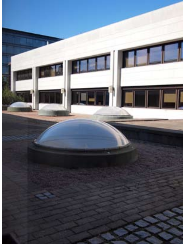
↑ Rakennuksen länsipuolen siipien välisillä sisäpihoilla on vielä jäljellä joi- tain alkuperäisvaiheen suuria kattokupuja. Etualalla alkuperäinen, taa- empana laajennusvaiheen kattokukunoita. amoy 2013
