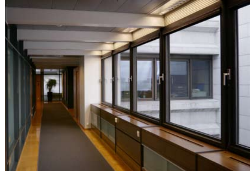
↑ Ikkunapenkkeihin liittyy ilmanvaihdon sekoitusyksikkö ja sekoitetun ilman jakokanavat. Kuva rakennusvaiheesta. LVI-Pohjolassa s. 37 ↗ Jakokanavan alapuolinen osa on käytetty kaappitilana siellä, missä ei ole sekoitusyksikköä. 10. krs:ssa kaapin ovet on vaihdettu lasiksi. amoy 2013
