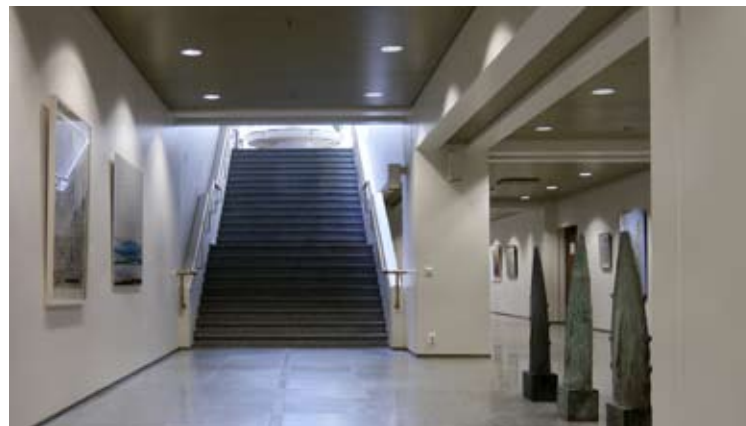
↓ Valokadun rakenteita 01. kerrostasolta. amoy 2013
