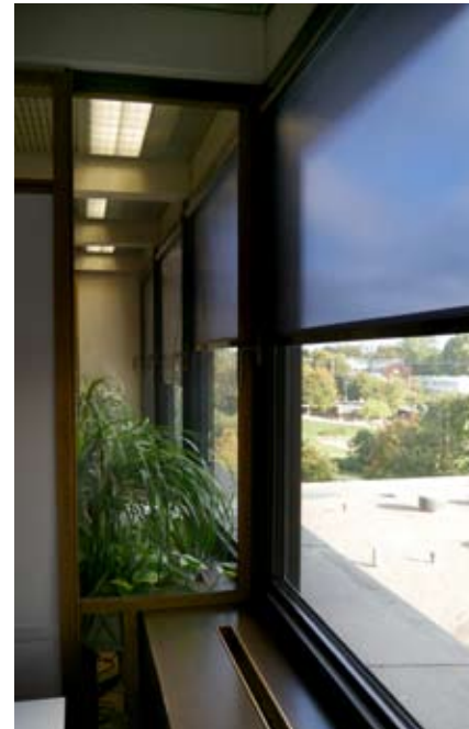
↑ Ikkunapenkkeihin liittyy ilmanvaihdon sekoitusyksikkö ja sekoitetun ilman jakokanavat. Kuva rakennusvaiheesta. LVI-Pohjolassa s. 37 ↗ Jakokanavan alapuolinen osa on käytetty kaappitilana siellä, missä ei ole sekoitusyksikköä. 10. krs:ssa kaapin ovet on vaihdettu lasiksi. amoy 2013
