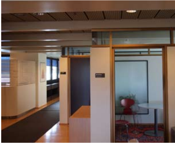
↑ Johdolle varatuissa A-tornin ylimmissä kerroksissa on siirrettävien väliseinien asemesta ylälasiseinät. Ilme on kuitenkin hyvin samankaltainen. amoy 2013
