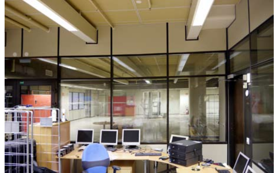
↑ Kerrostason 01 entiset ATK-salit ovat tällä hetkellä pääosin tyhjiillään. Väliseinäjärjestelmän ovat laajennusvaiheen väliseinäelementit hattulistoin. amoy 2013
