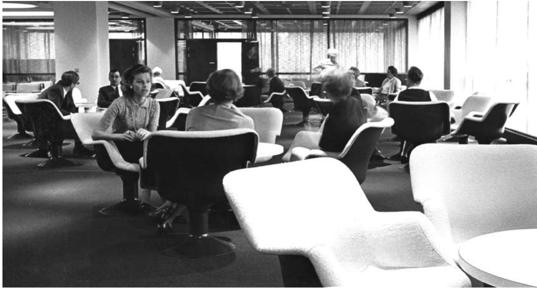
↑ Henkilökunnan seurusteluauula, taustaalla näkyvät lasiseinäiset kirjasto ja musiikkihuone. Pohjolan toimitalo, Arkkitehti-lehden esittelyaineisto, kuvat Risto Kamunen ja Matti Saanio. AmA
