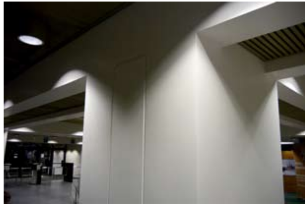
↑ Ohuempi betonivalu pilarin kyljessä on rajattu matalalla uralla. amoy 2013
