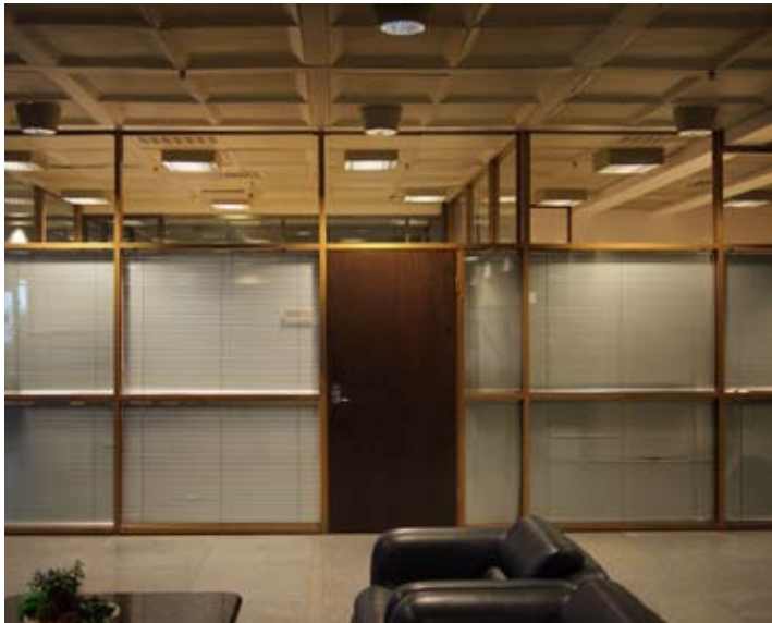
↑ 1. kerroksen alkuperäisissä vahtimestarin tiloissa on vanhoja alumiinilasiseinärakenteita eloksoidulla listoilla. amoy 2013
