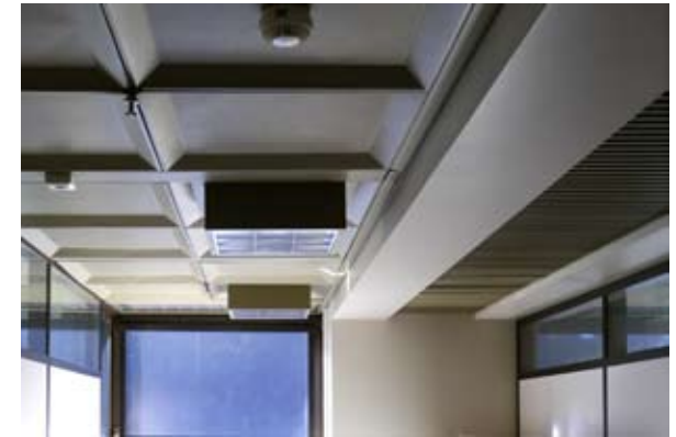
↑ Kaksoispilari ja rimasäleikkö osana toisen kerroksen alakatto- ja väli-seinämaailmaa. amoy 2013
