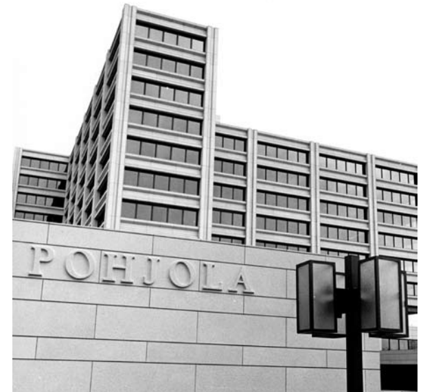
↑ Pohjolan toimitalo Lapinmäentieltä valmistumisensa jälkeen. Pohjolan toimitalo, Arkkitehti-lehden esittelyaineisto, kuvat Risto Kamunen ja Matti Saanio. AmA
