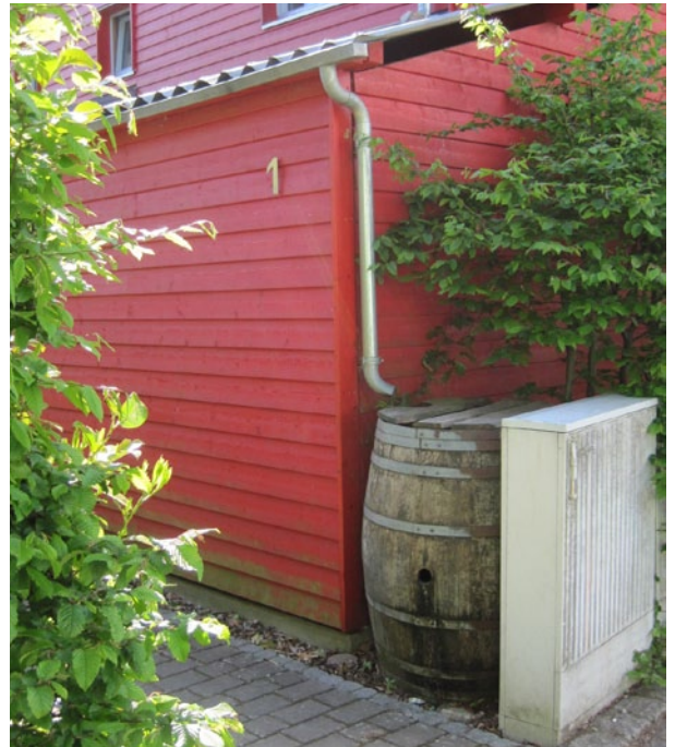
Esimerkki kattovesien keräämisestä kasteluveteeksi. Freiburg, Saksa.
