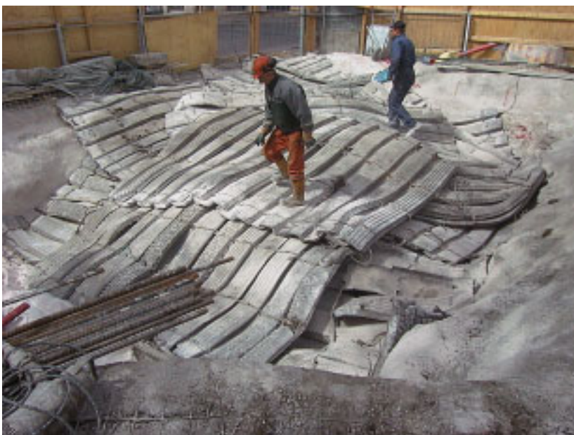
Louhintakentän peittäminen. Juha Halonen
