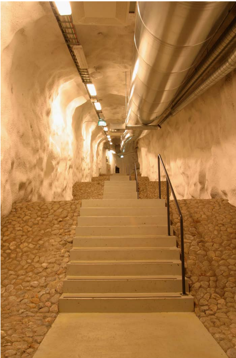
Kuva 20. Kampin työtukikohdan jalankulkuyhteys
