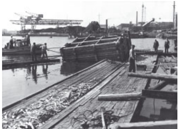
Sörnäisten satama, silta-arkun työmaa 1955
