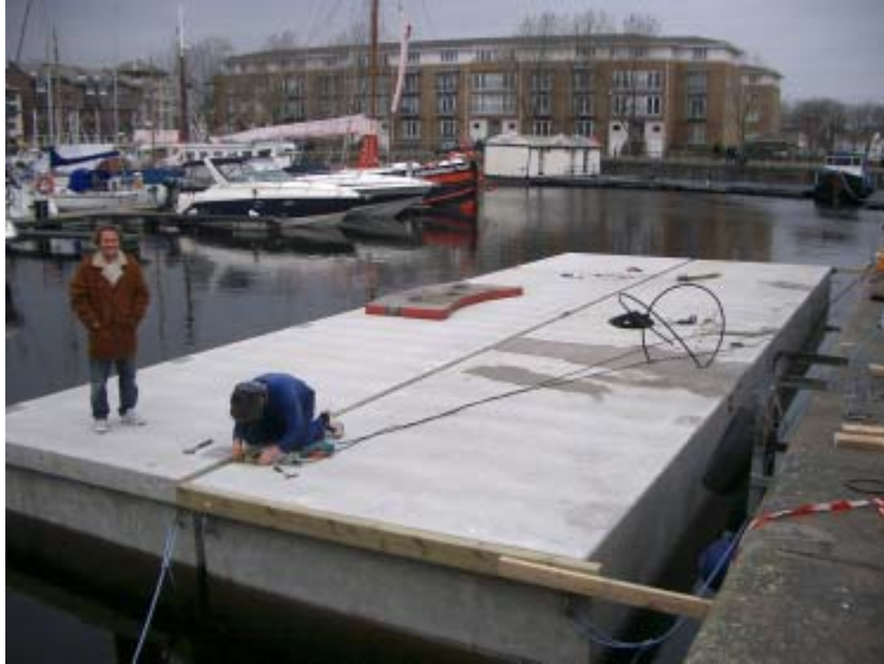
Kuva 28 Kelluvia ponttonimoduuleja kytkettynä Lontoossa. (Marinetek Finland Oy)
