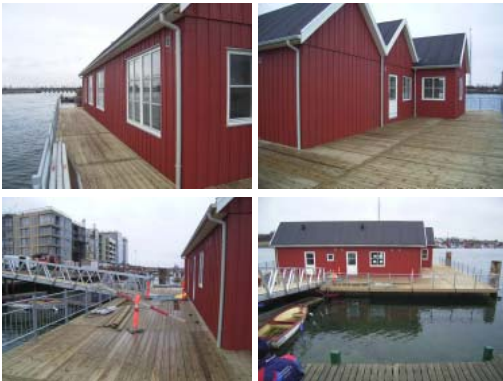
Kuva 10 Rakennusta kiertää pieni perustuksista ulos vedetty laituri. (Marinetek Finland Oy)
