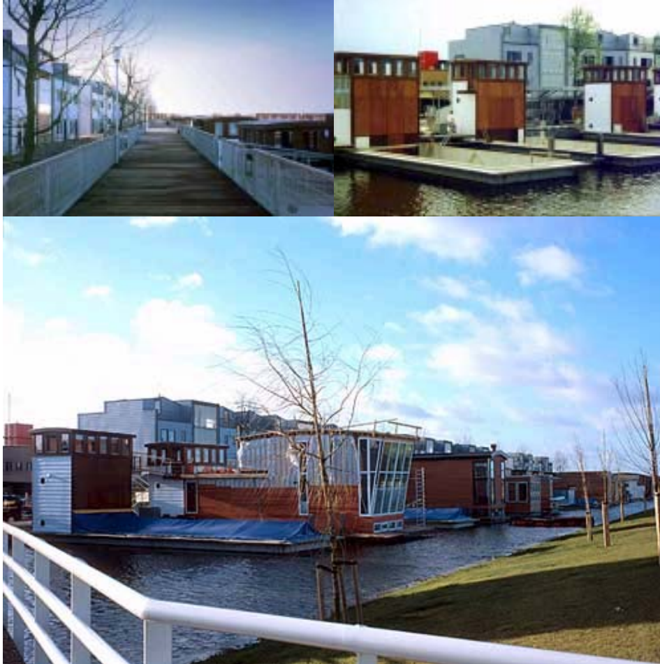
Kuva 3 Veden ylle rakennettuja kelluvia asuntoja. Talojen mantereen puoleinen puoli on kaikissa hyvin samanlainen, mutta veden puoleinen osa on yksilöllinen ja selvästi suurempi.
