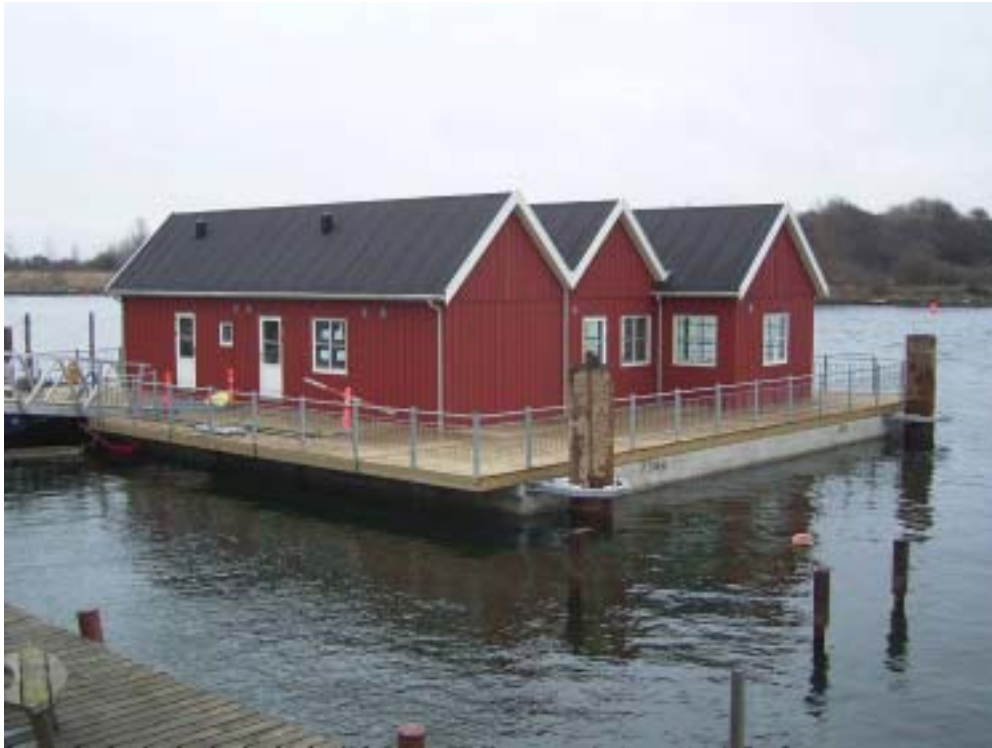
Kuva 9 Tanskassa Kööpenhamin Sydhamniin Sluseholmeniin toteutettu kolmesta rakennusmoduulista rakentuva klubirakennus. (Marinetek Finland Oy)
