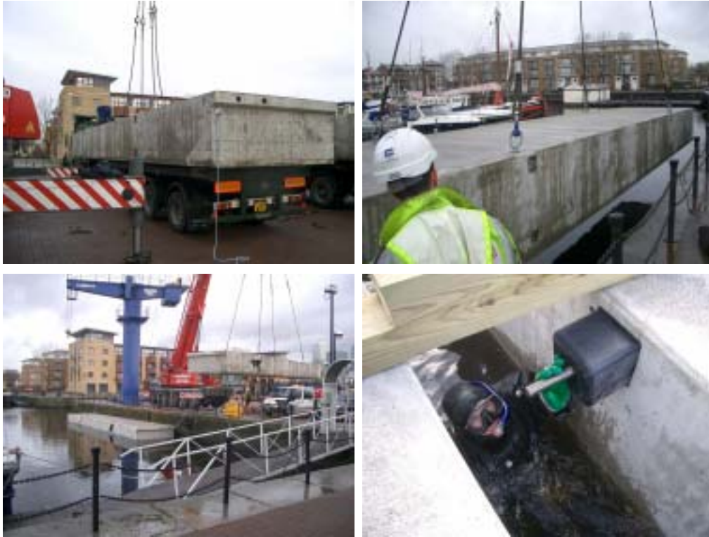
Kuva 30 Ponttonielementit on taloudellisinta valmistaa erillisessä tehtaassa ja kuljettaa maata vesiteitse lopulliseen sijoituspaikkaansa. Ponttonit kytetään toisiinsa paksuin terästangoin, minkä jälkeen ne ankkuroidaan pohjaan. (Marinetek Finland Oy)
