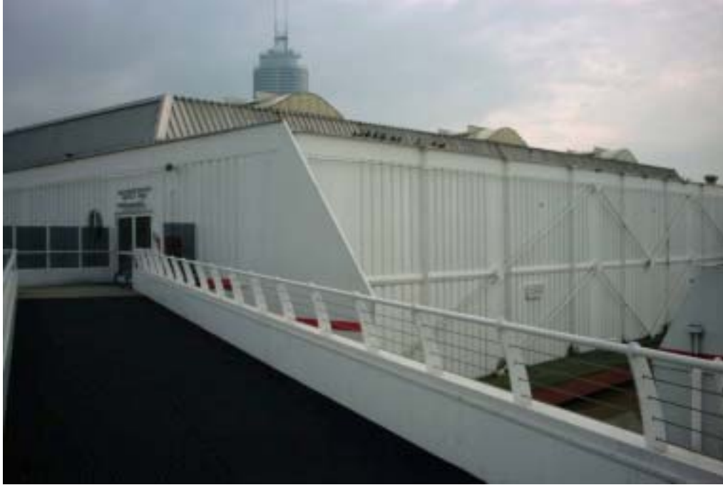
Kuva 15 Urheiluhalliin käydään veden pinnan liikkeitä myötäilevää siltaa pitkin.
