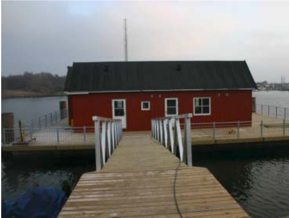
Kuva 24 Veden pinnan korkeuden vaihtelu asettaa merkittäviä vaatimuksia mm. käyntisillan pituudelle ja kaltevuudelle, rakenteelliselle lujuudelle ja kunnossapidettävyydelle – etenkin jos siltaa pitkin kuljetaan myös autoilla. Raskas käyntisilta edellyttää myös raskastekoista rannimmaista ponttonia, joka pystyy kantamaan käyntisillan painon. (Marinetek Finland Oy)
