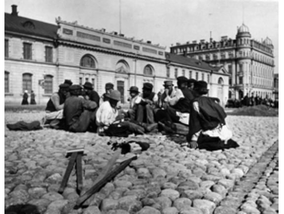
Venäläisiä katutyöntekijöitä 1900-luvun vaihteessa. HKM
