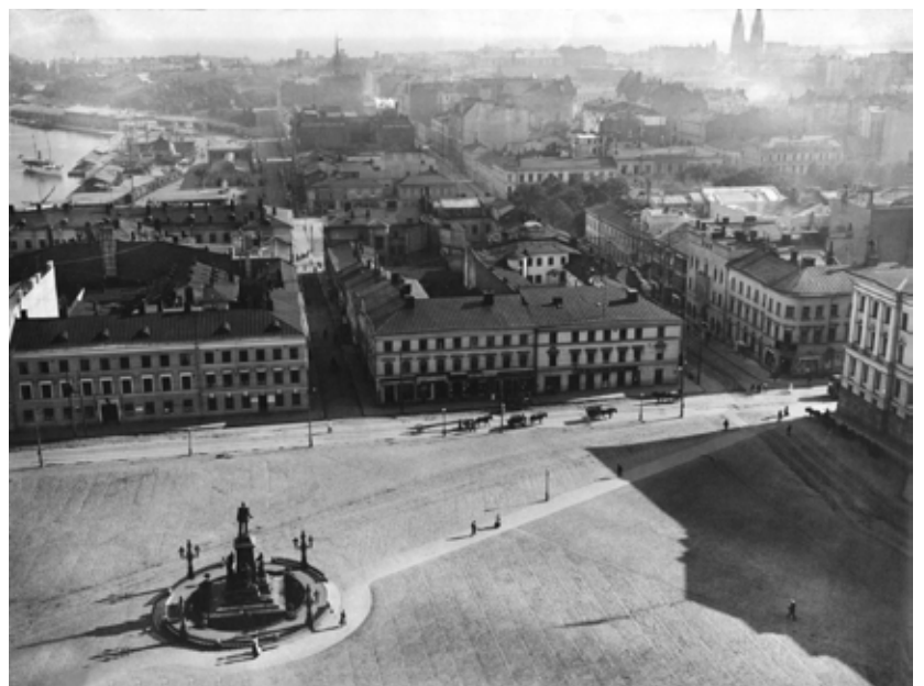
Näkymä kirkon katolta. 1890-luvulla toteutettu, nupukivellä päällystetty kulkureitti ohittaa keisarin muistomerkin kaarteessa. Myös Aleksanterinka- dulla on nupukiveystä. Signe Brander 1909. HKM
