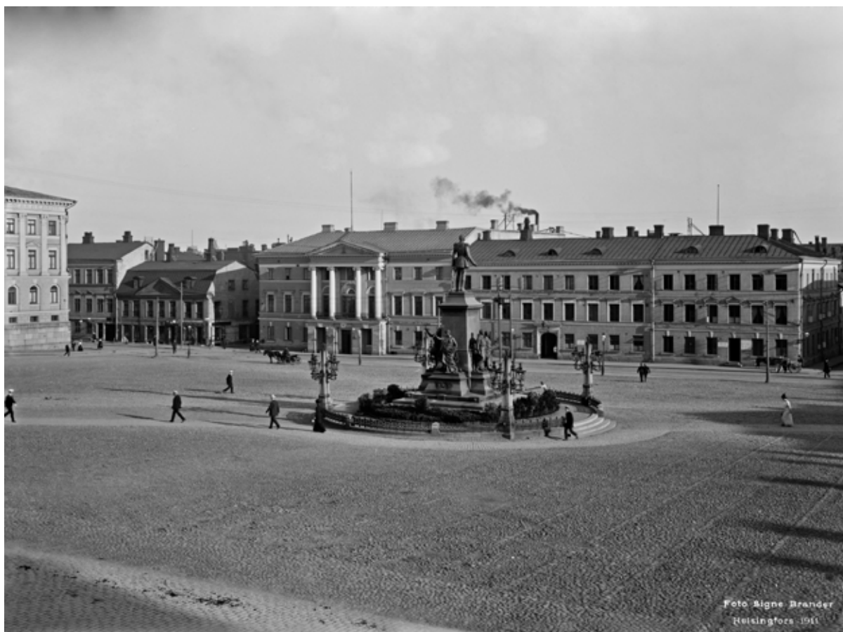
Senaatintori vuonna 1911. Kuvan tarkkuus tuo selvästi esiin kiveyksen yksityiskohtia ja jakoa osiin. Etualalla Hallituskadun nupukivet ajorata. Signe Brander. HKM
