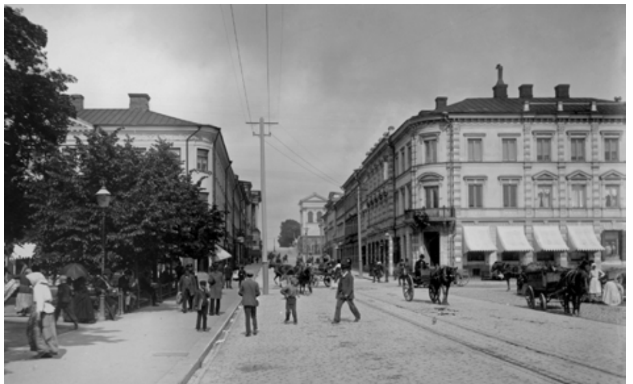
Kappellesplanadi, Unioninkatu ja Kauppatori 1890-luvulla. Näkymä pohjoiseen. Kadun päällysteet ovat muuttuneet: jalkakäytävä on päällystetty asfaltilla ja rajattu graniittireunalla, ajoradalla on nupukiveys. Uudistunutta katukuvaa täydentävät raitiovaunukiskot. K. E. Ståhlberg. HKM
