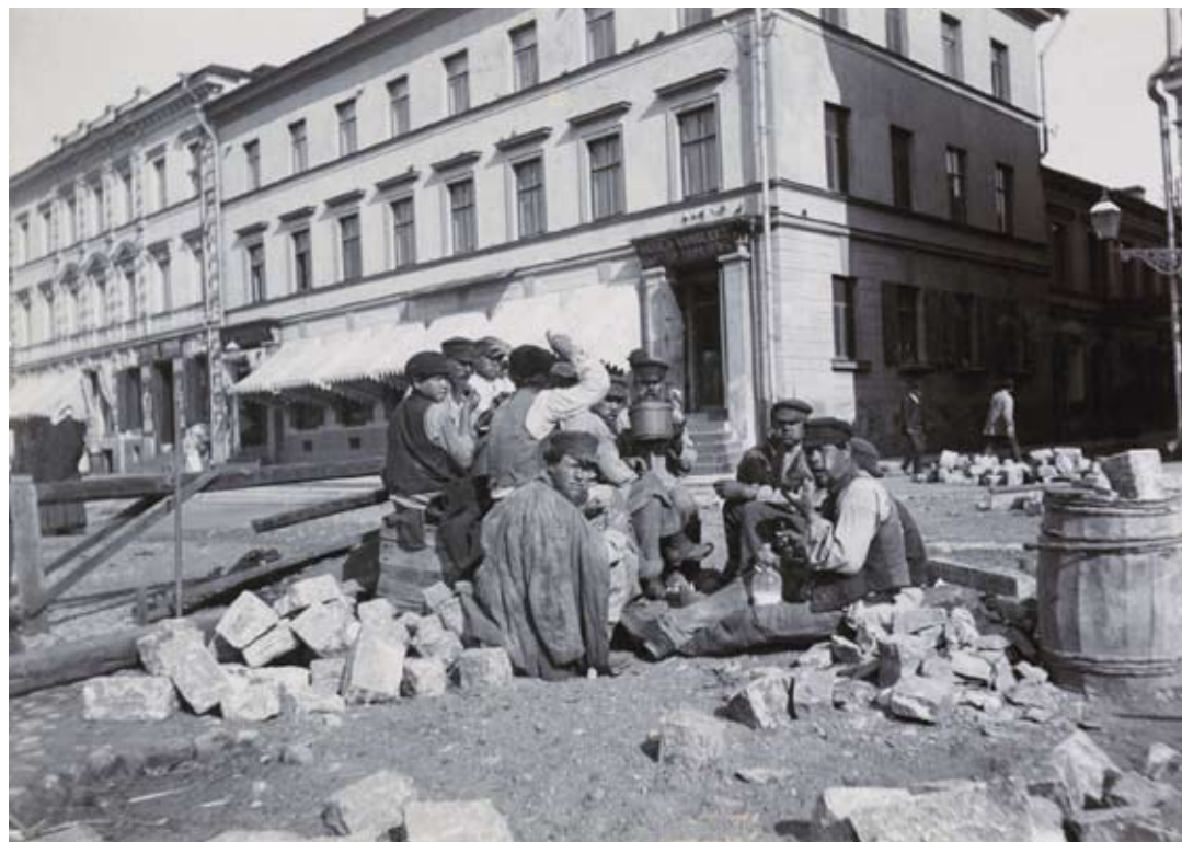
Venäläisiä katukiviyöntekijöitä 1890-luvun alkupuoliskolla, Pohjoisesplanadin ja Sofiankadun risteyksessä. Etualalla vasemmalla näkyy avattua mukulakiveystä, oikealla jalkakäytävän uutta muotoiltua reunakiveä. Tuntematon kuvaaja. HKM
