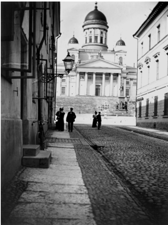
Sofiankatu 1890-luvulla. Jalkakäytävän päällysteenä on julkisivun puolella kapea mukulavyöhyke, ulompana isokokoinen kivilaatta ja reunalla leveä mukulakivivyöhyke. Katuoja on muotoiltu mukulakivistä. Kadun päällysteenä on mukulakivi. Nils Wasastjerna 1895. HKM
