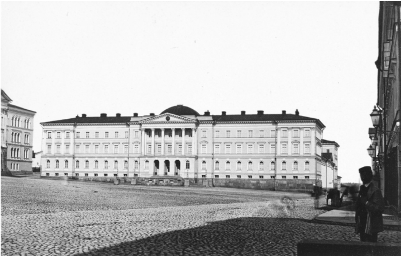
Näkymä Senaatintorin yli kohti Senaatintaloa 1870-luvulla. Oikealla Aleksanterinkatu. Kadut on päällystetty mukulakiveyksellä. Jalkakäytävien päällysteenä on mukulakiveä ja kivilaattaa, katuojat on muotoiltu mukulakivestä. Carl Adolf Hårdh. HKM
