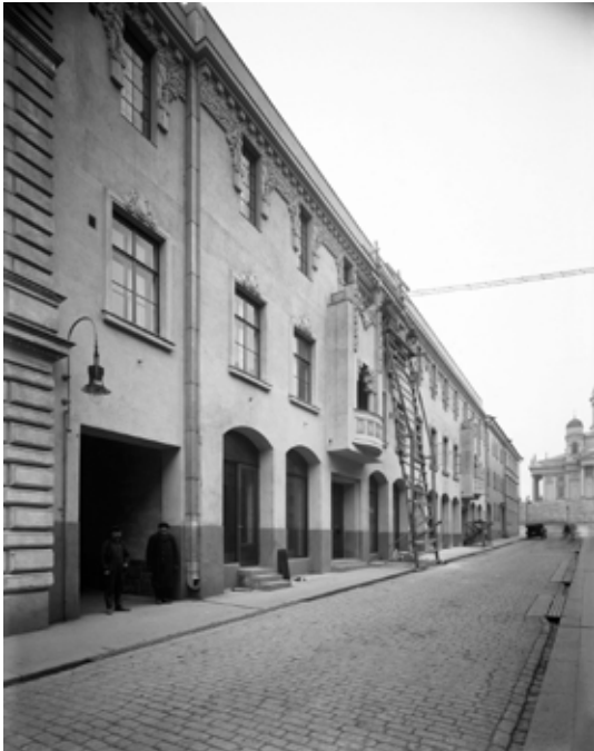
Sofiankatu 1912. Jalkakäytävien päällysteenä on asfaltti ja ajoradan päällysteenä nupukiveys. Kiveys toteutettiin 1900-luvun vaihteessa. Eric Sundström. HKM
