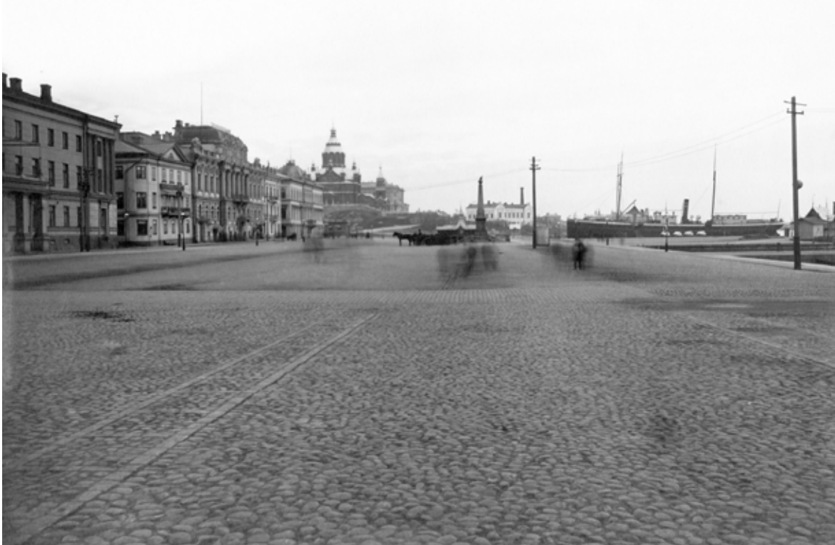
Etualalla Kauppatorin myyntialueiden mukulakiveys. Myyntirivien jako on merkitty nupukivirivein. Sofi- ankadun kohdalla päällyste vaihtuu nupukiveksi. Ajoradan pinta on muotoiltu kuperaksi. A. E. Rosenbröijer 1895. HKM
