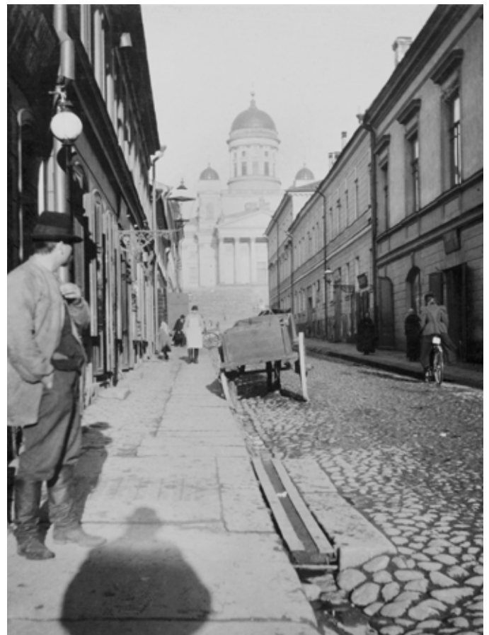
Sofiankatu 1900-luvun alussa. Isot kivilaatat ovat nyt jalkakäytävän reunalla ja julkisivun puolella on leveä mukulakivivyöhyke, katuoja ja kadun päällyste kuten edellä. Tuntematon kuvaaja. HKM
