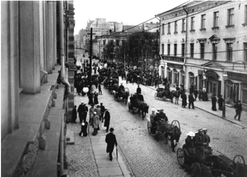
Unioninkatu, vappuajo 1.5.1906. Kuva on otettu Aleksanterinkadun kulmasta kohti etelää. Kadun päällysteenä on nupukiveys, jalkakäytävillä on isoa graniittilaattaa ja nupukiveystä. Kokonaisuutta täydentävät graniittireunakivet ja nupukivestä rakennetut katuojat. Nils Wasastjerna. HKM
