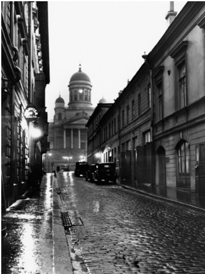
Sofiankatu 1930. Jalkakäytävät ovat asfalttia, reunakivi hakattua graniittia. Kadun päällysteenä on nupukiveys. Katuojien kantena on käytetty rautaritilää. Foto Roos 1930. HKM
