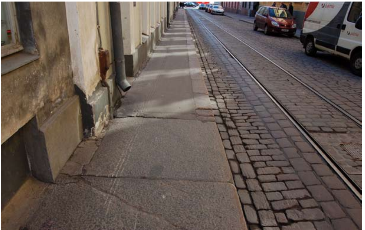
Sederholmin talon jalkakäytävällä on massiivista graniittilaattaa. Muilta osin itäsivun jalkakäytävä on 1900-luvun vaihteessa yleistyneeseen tapaan päällystetty asfaltilla ja rajattu graniittireunakivellä.
