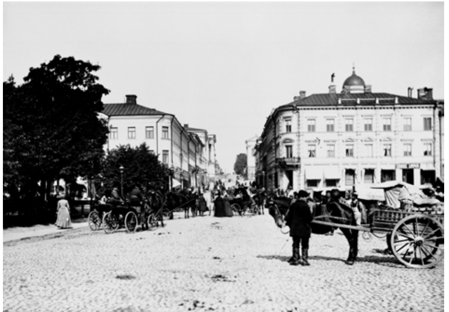
Unioninkatu Kauppatorin kohdalla v. 1890, näkymä pohjoiseen. Katu on vielä toistaiseksi päällystetty mukulakivillä. Jalkakäytävällä on isojen kivilaattojen muodostama tasainen kulkuväylä. Daniel Nyblin. HKM
