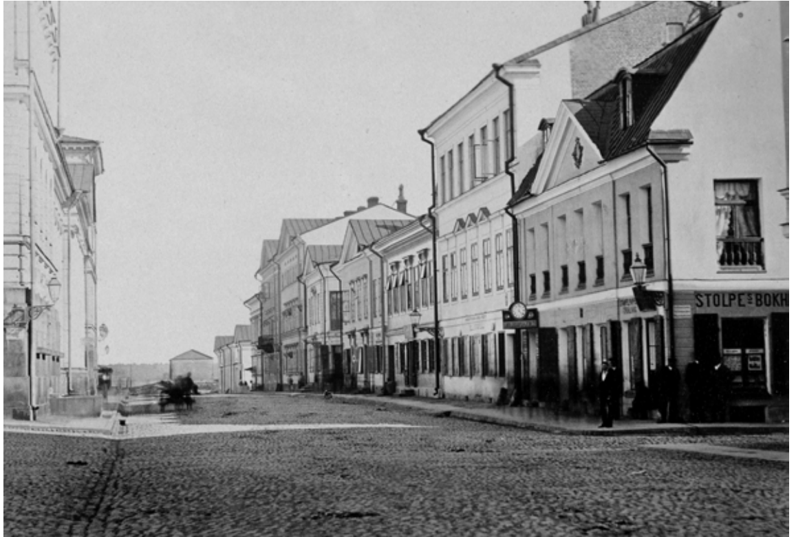
Senaatintorin kaakkoiskulma ja mukulakivet Aleksanterinkatu 1870-luvulla. Jalkakäytävillä on yhdistetty mukulakiveä ja kivilaattaa. Katuojat on muotoiltu mukulakivestä. Carl Adolf Hårdh. HKM
