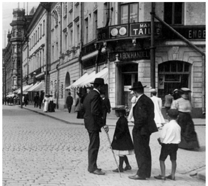
Nupukivipäällysteet yleistyivät 1900-luvun vaihteessa, samoin jalkakäytävien asfalttipinnat. Pohjoisesplanadin ja Unioninkadun kulman. 1905 (osa kuvasta). Nils Wasastjerna. HKM
