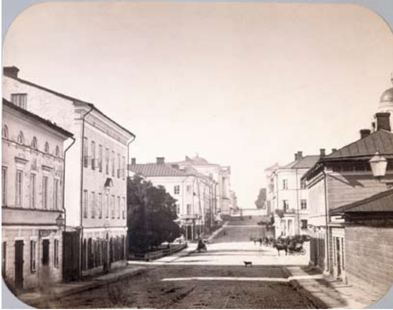
Unioninkatu n. 1870. Näkymä Esplanadin yli kohti pohjoista. Kadun pinta on mukulakiveä, jalkakäytävät isokokoista kivilaattaa ja mukulakiveä. C. A. Hårdh. HKM
