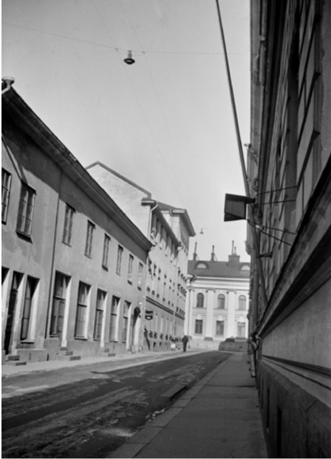
Helenankatu 1940-luvun lopulla. Ajoväylän ja jalkakäytävien päällysteenä on asfaltti. Helenankatu ei sisällynyt vuoden 1911 kiveysesitykseen, eikä katu ollut vielä päällystetty nupukiveyksellä vuonna 1927. Ilmari Raekallio. HKM
