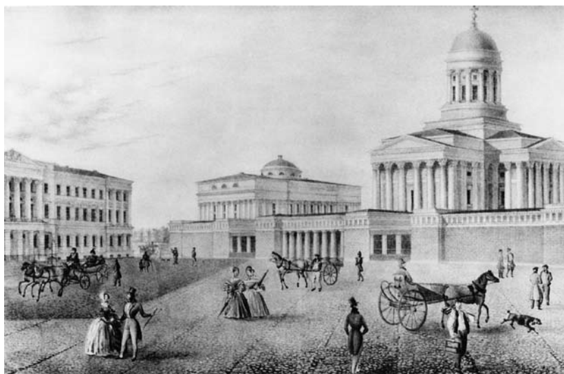
Torinäkymä vuonna 1838. Oikealla näkyy myöhemmin purettu päävartio. Mukulakiveys on jaettu osiin pitkittäisillä kivriveillä. Samanlainen kiveystapa säilyi 1900-luvun alkuun. F. Tengström. HKM
