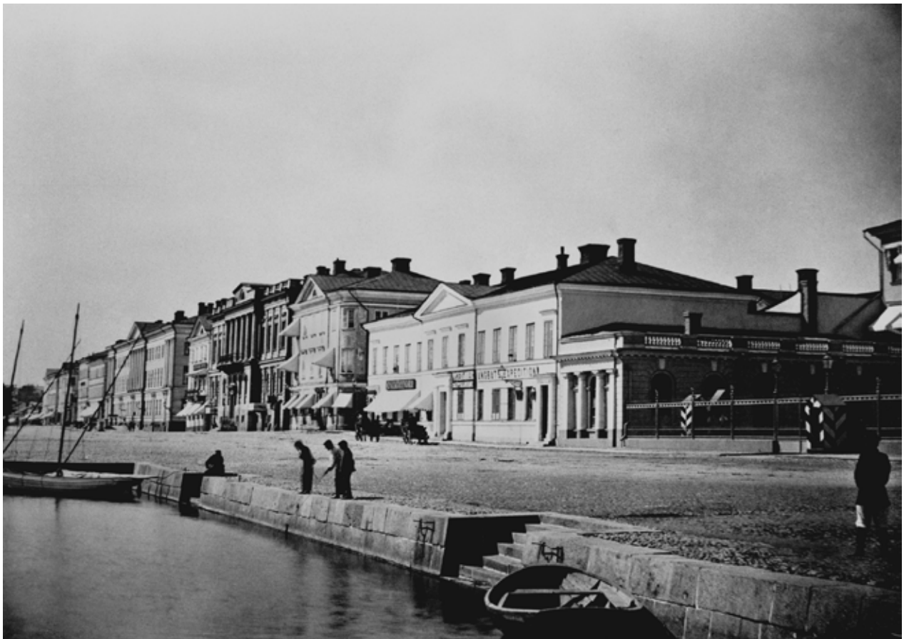
Kauppatorin itäosa graniittiharkoista rakennettuine rantamuureineen 1870-luvulla. Torialueen päällysteenä oli mukulakiveys aina 1900-luvun alkuvuosille saakka. Charles Riis. HKM
