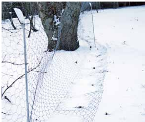
Kuva 50. Tukikepit laitetaan tukevasti ja suoraan noin 2–3 metrin välein suojattavan kasviryhmän ympärille. Verkko asennetaan paikalleen samalla alareuna taittaen. Verkko kiinnitetään tukikeppeihin nippusiteillä tai sinkilöillä.
