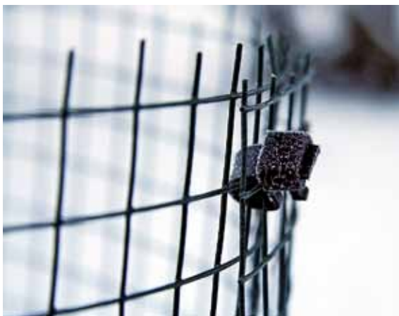
Kuva 47. Metalliverkon sivujen sitominen yhteen nippusiteillä. Nippuside siistitään leikkaamalla tarpeeton siteen osa.
