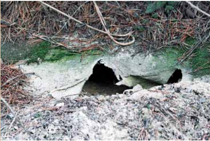
Kuva 58. Kanin käytävän suuaukko rautatien luiskan pensasalueella, jossa maan katteena on käytetty katekangasta.
