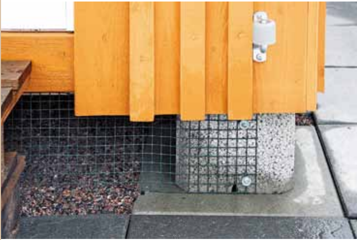
Kuva 56. Siirtolapuutarhamökin alusta on suojattu metalliverkolla. Verkon alareunan upottaminen tai taittaminen ei ole aina tarpeellista eikä edes mahdollista.
