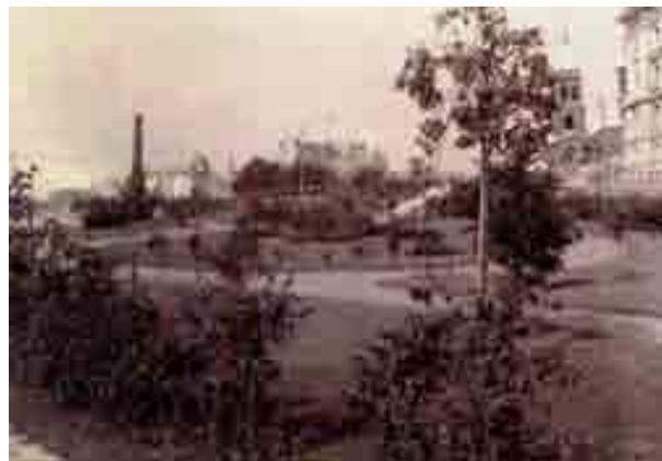
Puisto toteutettuna. Kuvassa on valmis keskialueen istutus, Luotsikadun reunan pensas- ja puuistutukset, Rahapajankadun reunan pensasalue, kirkon tasolle vievät portaat ja Pormestarinrinteen luiskan pensasis-tutusalue. HKM.
