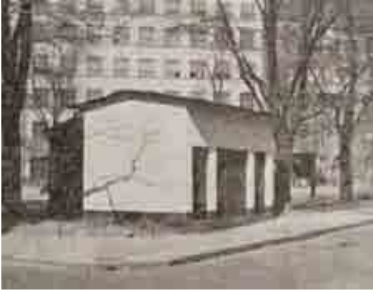
Vastavalmistuneen puistomuuntamon takana on vielä vanha puinen kioskirakennus. Pensaita ei vuonna 1947 otetussa valokuvassa puistikossa näy. Harmia.
