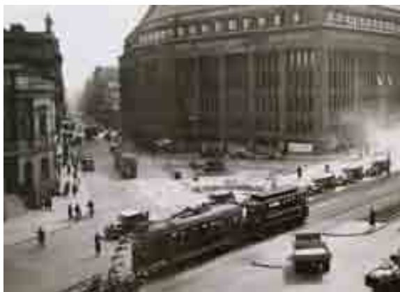
Kolmen sepän patsaan ympäristö rakenteilla 1930-luvun alussa. Heikinesplanadin puut on kaadettu. HKM.
